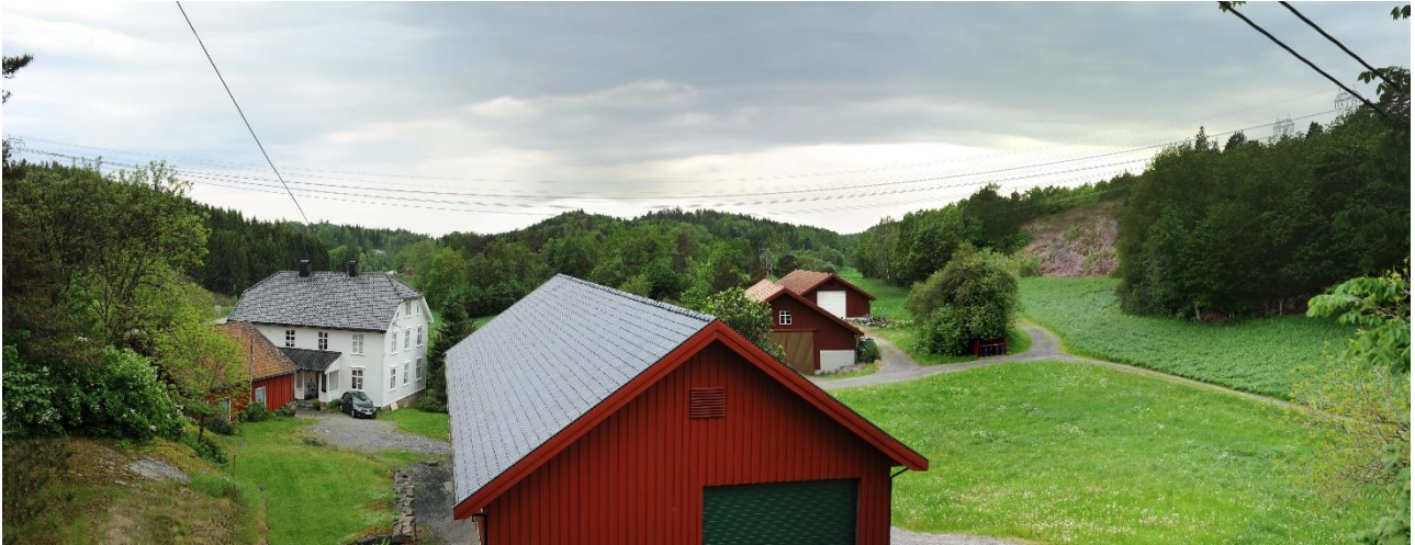
Figur 4-29. Oppdatert fotovisualisering av Løsning 2 ved Dalen. To nye ledninger føres i ny trasé litt lengre unna boligen. Dagens 132 kV-ledning føres parallelt med nye ledninger. Eksisterende 66 kV-ledning beholdes. Man kan skimte fylkesvei 421 bak det hvite huset. Se vedlagte fotovisualiseringer for høyere oppløsning og større bilde.
