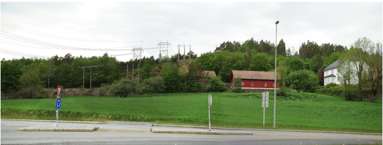
Figur 4-30. Fotovisualisering av Løsning 1 ved Dalen. Eksisterende 132 kV-ledning beholdes og nye ledninger føres vest for disse. Se vedlagte fotovisualiseringer for høyere oppløsning og større bilde.
