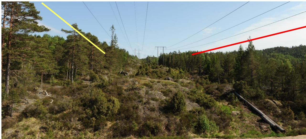
Figur 4-23. Bilde fra grusvei i skogen vest for Siring stall som vanligvis er sperret med bom for uvedkommende. Ledningene midt i bildet er dagens 132 kV- og 66 kV- ledninger (hhv. til venstre og høyre). Løsning 1 (rød) og 2 (gul) parallellføres på hver sin side av dagens ledninger, hver av løsningene vil medføre et samlet ryddebelte med bredde på ca. 100 meter. Nye fagverksmaster vil bryte mer med landskapet enn H-mastene vi ser i bildet.
