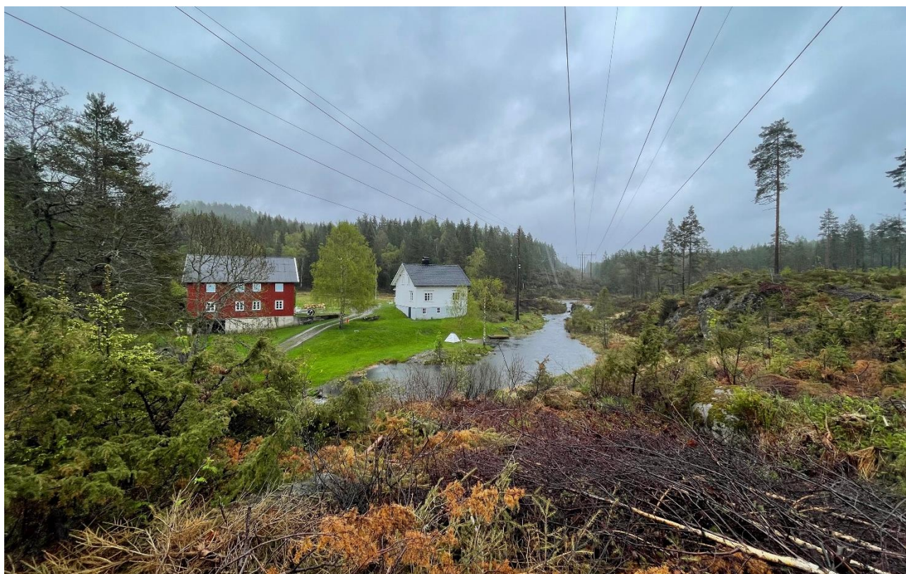
Figur 4-2. Vålansmyr sørøst for Monehagen transformatorstasjon. Ledningene i bildet er dagens 132 kV- og 66 kV-ledning, og setter lokalt preg på omkringliggende vassdrag og bebyggelse.
