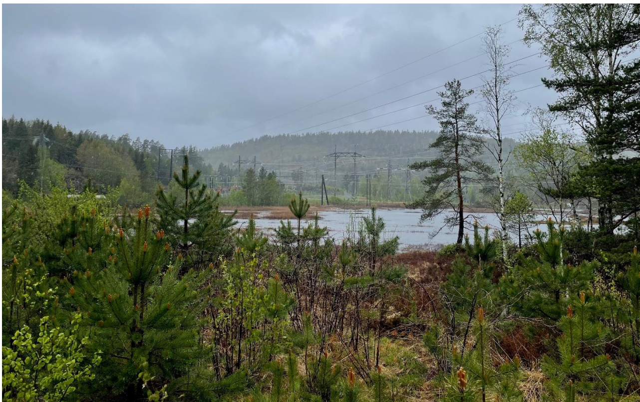
Figur 4-3. Monehagen transformatorstasjon sett fra grusveien som går videre til Arendal transformatorstasjon. Myrområdet og vannet som ses i forkant av stasjonen er en del av Mossevatnet.
