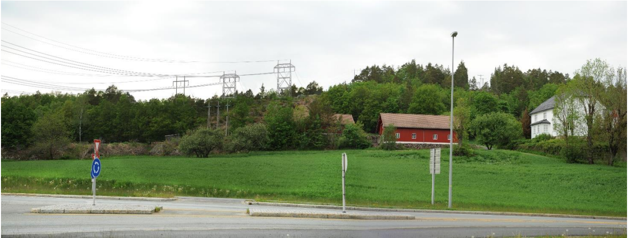
Figur 4-31. Fotovisualisering av Løsning 2 ved Dalen med både fagverksmaster og komposittmast. To nye 132 kV-ledninger føres opp som fagverksmaster i stål. Dagens 132 kV-ledning legges om og føres opp parallelt med nye master i kompositt. Se vedlagte fotovisualiseringer for høyere oppløsning og større bilde.
