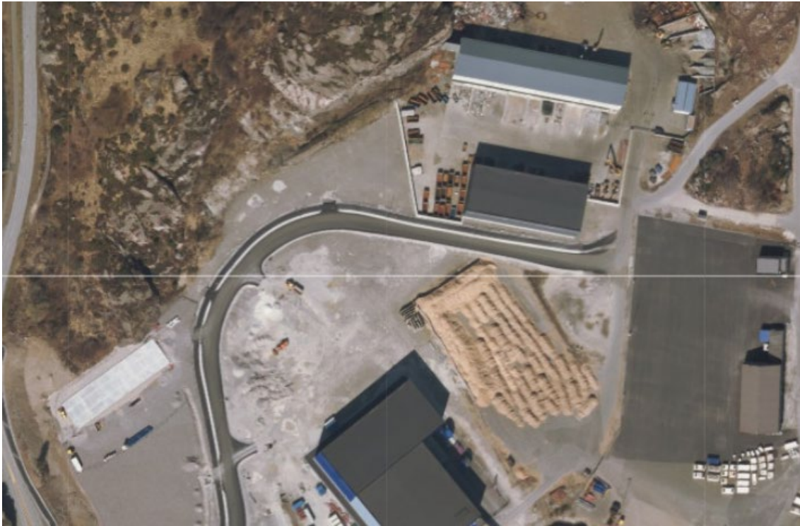
Figur 5-2 Oversiktsbilde fra tiltaksområdet
