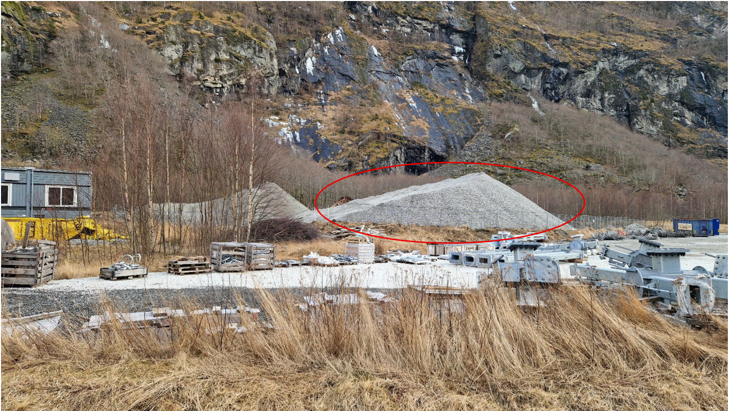
Bilde 8 Statnetts eksisterende masselager sett fra fv. 50 pr 4. mars 2026. Brakkeriggen er såvidt synlig i venstre bildekant og østlig del av lagerarealet til høyre. Som et sammenligningsgrunnlag rommer haugen som er avmerket i bildet ca. 4100 m 3 pukk.
