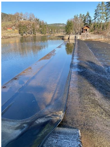
Kjeldal dam 2022. Gummiluka lagt ned på bunnterskel.
