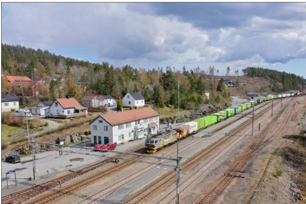
Figur 11-4 Nelaug stasjon med tilleggende arbeiderboliger i dag. Kilde: Bane Nor.
