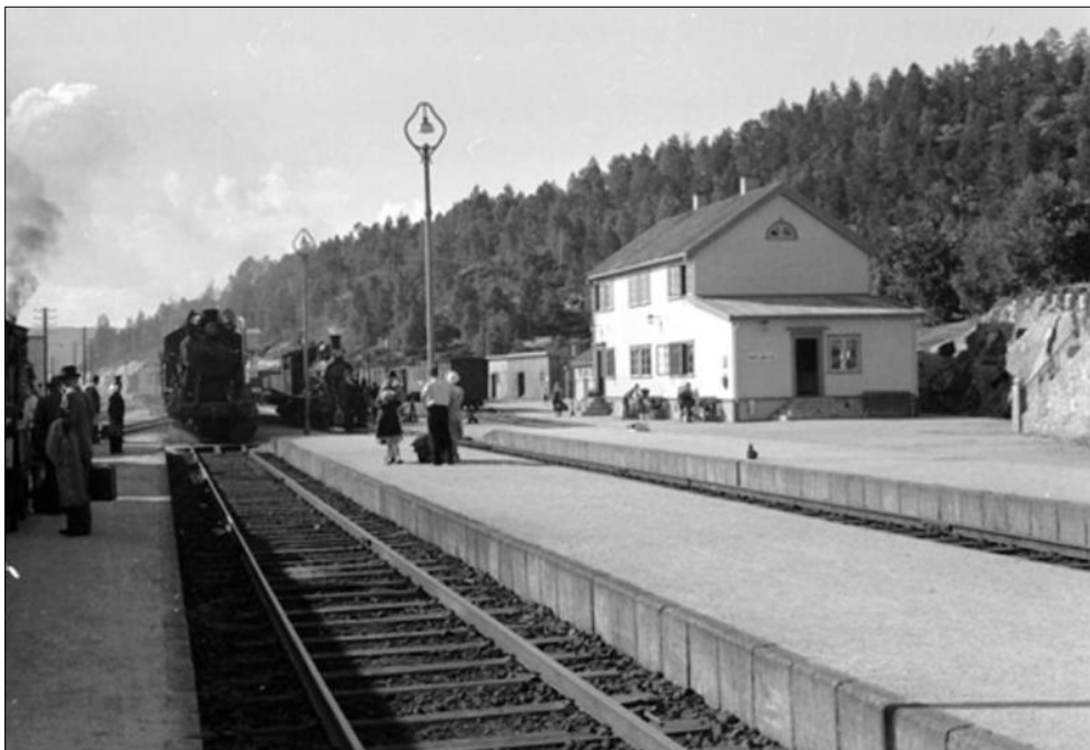
Figur 11-3 Nelaug stasjon med den opprinnelige utformingen. Kilde: Digitalt museum.
