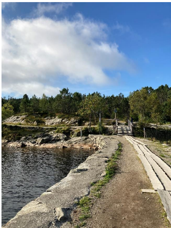
Figur 6. Hoveddammen sett mot Storevatnets utløp i sprengt kanal med gangbro over.
