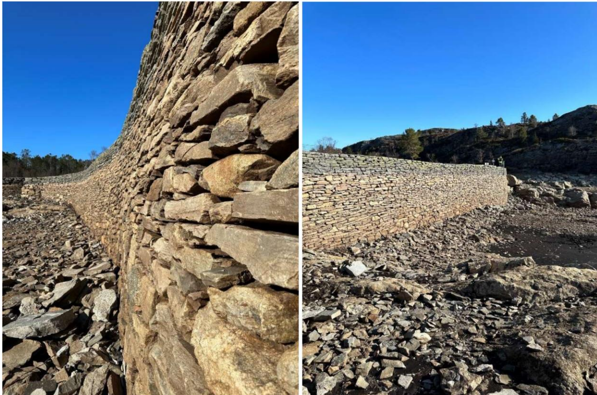
Figur 1. Dam Storevatnet hoveddam innside.
