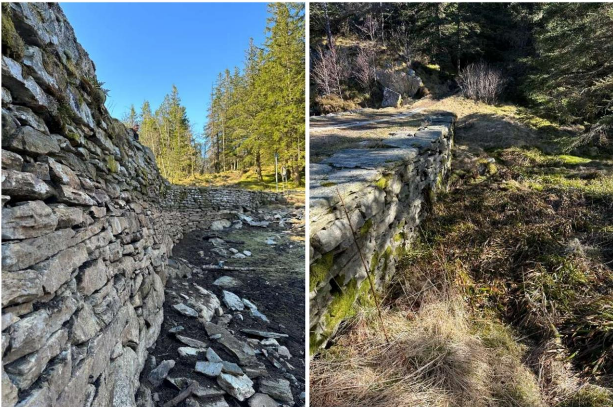
Figur 4. Dam Storevatnet S.
