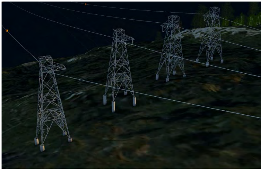
Fire stålmaster i fagverk blir stående på hver side av Saltstraumen
