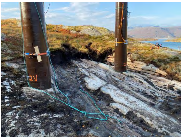
Figur 3-3 Illustrasjon av komposittmast fundamentert på fjell med slisseboring til venstre og i jord med rør til høyre.
