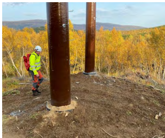
Figur 3-3 Illustrasjon av komposittmast fundamentert på fjell med slisseboring til venstre og i jord med rør til høyre.
