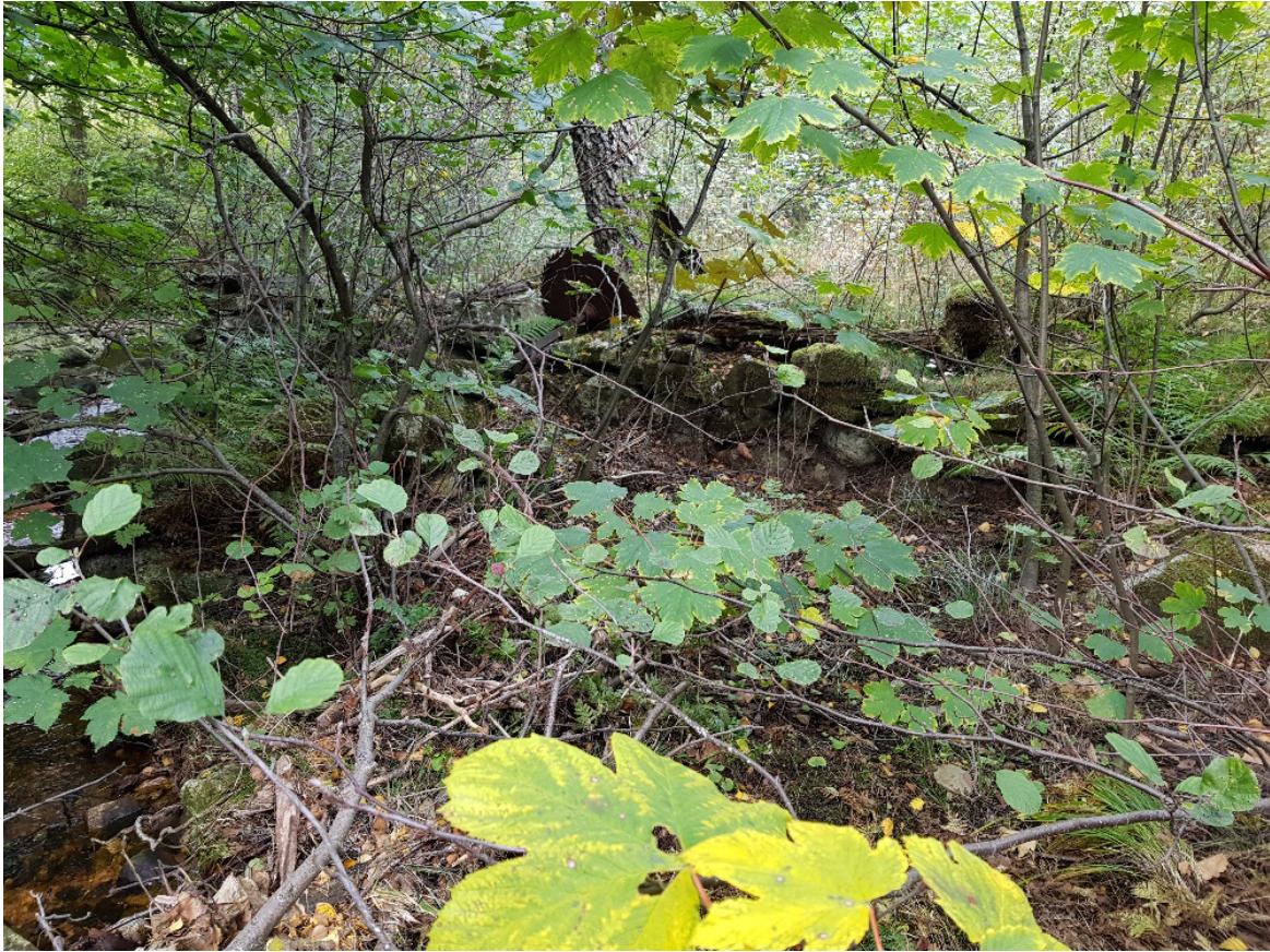
Figur 4: Restar av sirkelsagbruk i elva der søre ende av transformatorstasjonen er planlagt.
