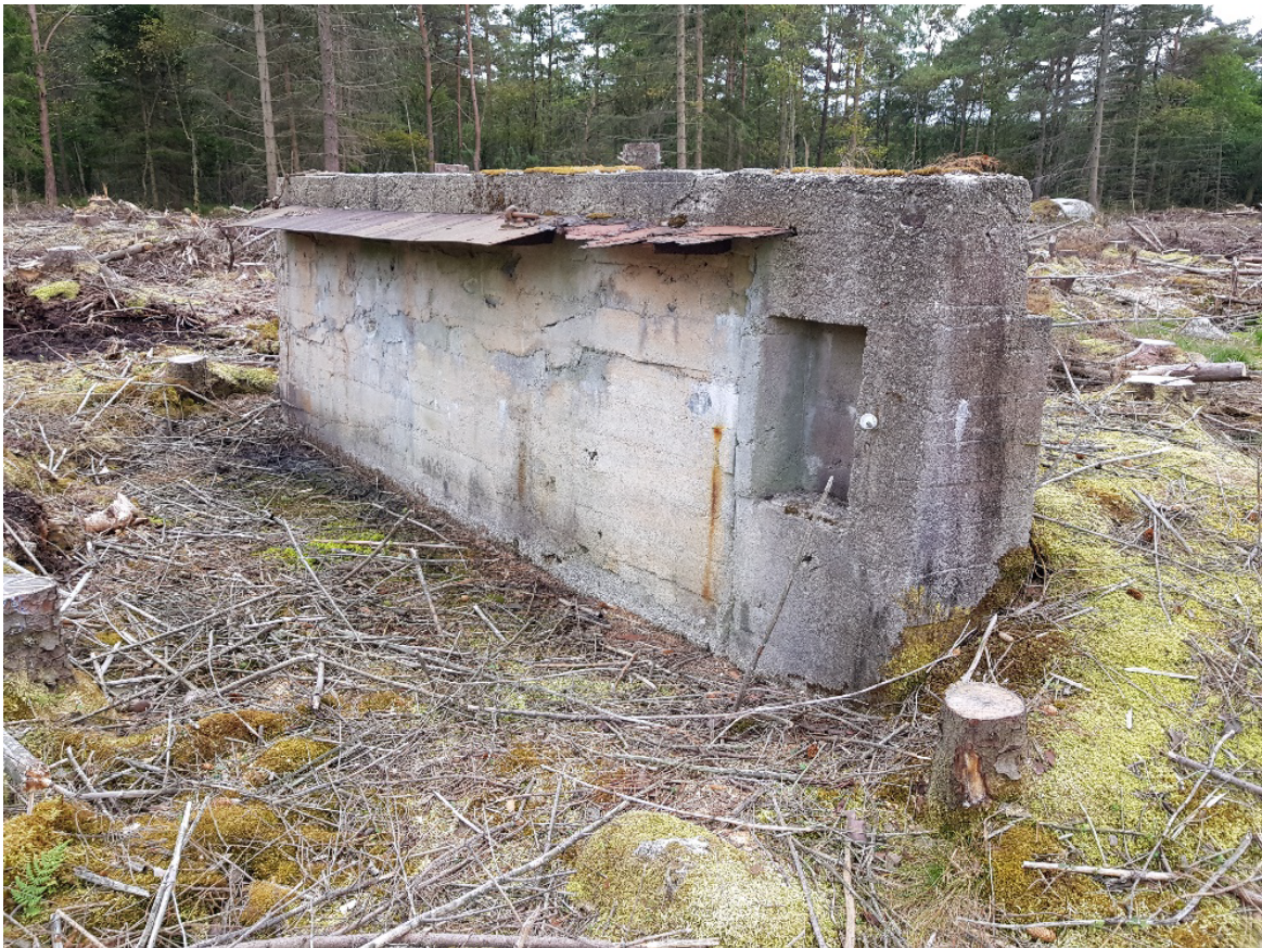
Figur 5: Grava til eldre skytebane der transformatorstasjon er planlagt.
