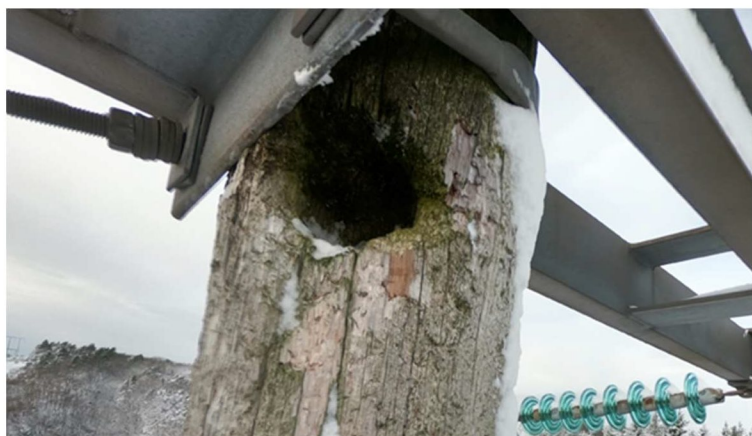
Figur 2-3. Eksempel på hakkespetthull i tremast.
