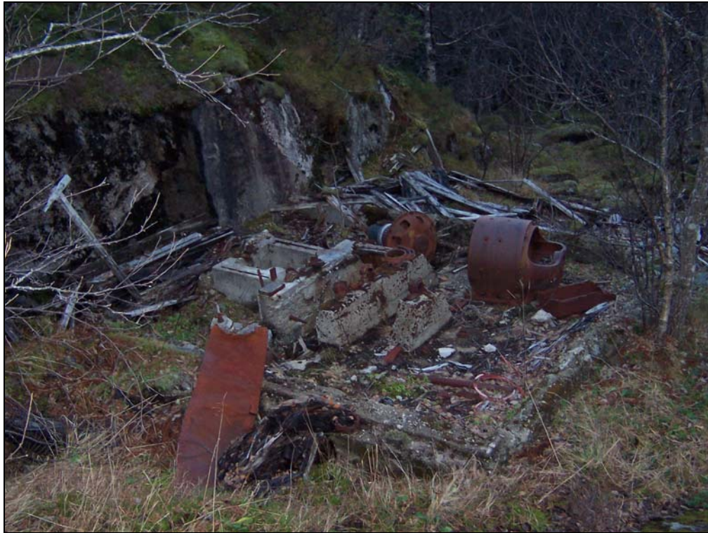
Bilde 10: Rester etter tidligere kraftstasjon i vassdraget.
