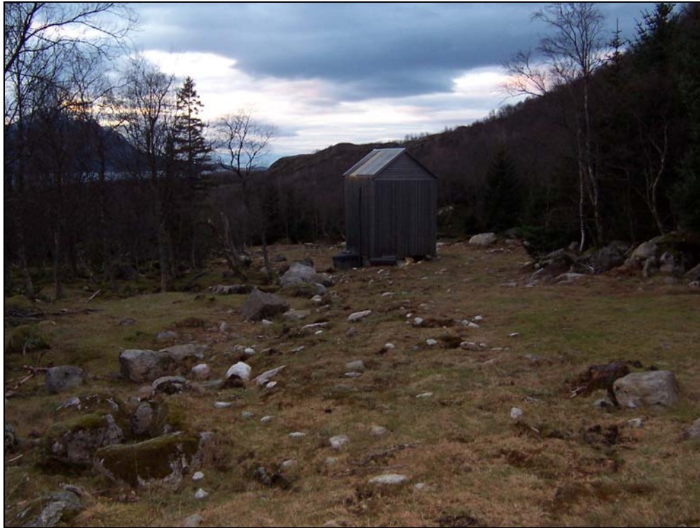
Bilde 12: Eksisterende vannverksbygning.
