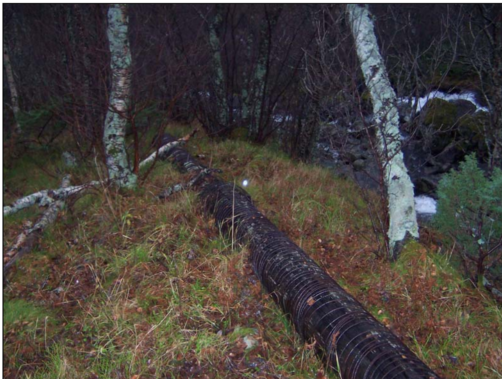
Bilde 11: Rester etter tidligere rørgate i forbindelse med kraftverksdrift i vassdraget.
