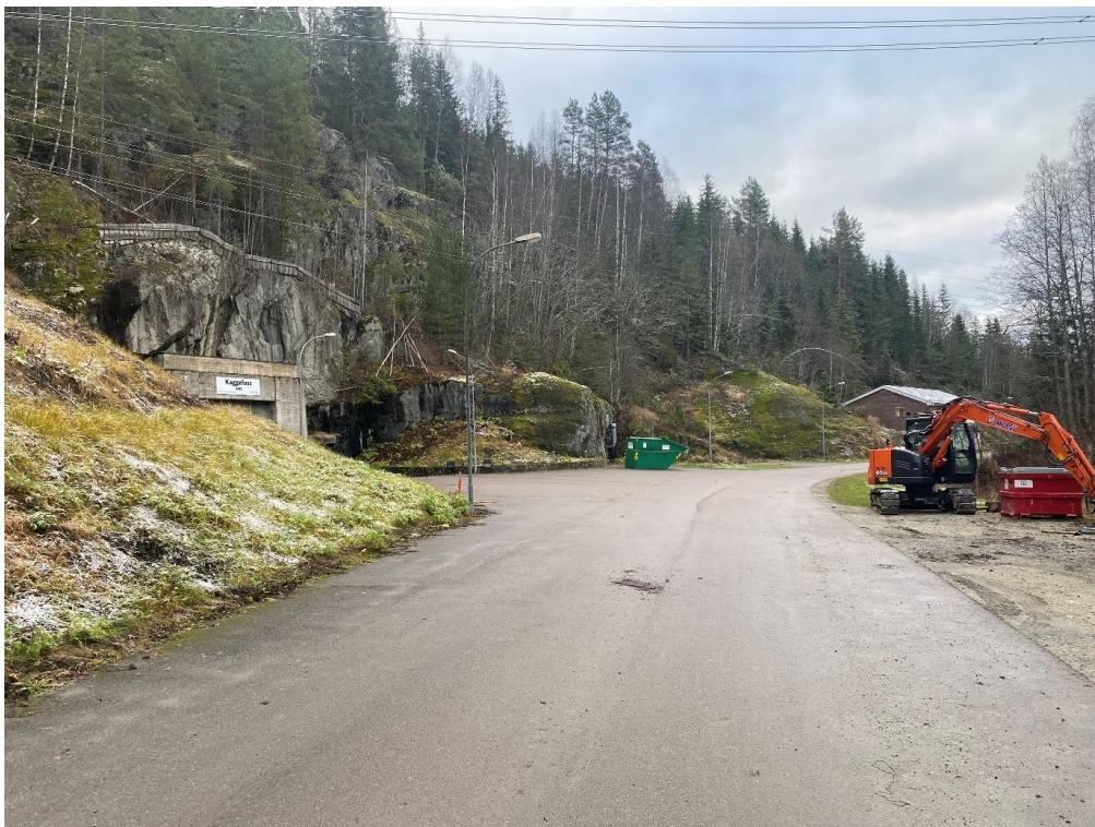
Figur 19 Bildet er tatt fra samme sted som forrige, men mot sør. Inngangen til kraftstasjonen til venstre.
