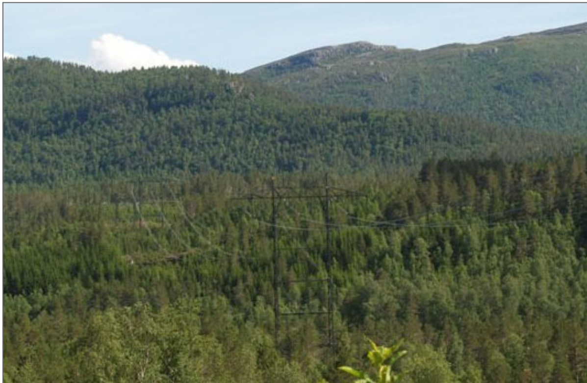
Figur 21: Bilde av kamuflert kraftledning. Linene er mattet, og isolatorene er av kompositt i stedet for av glass som er vanligst å benytte.
