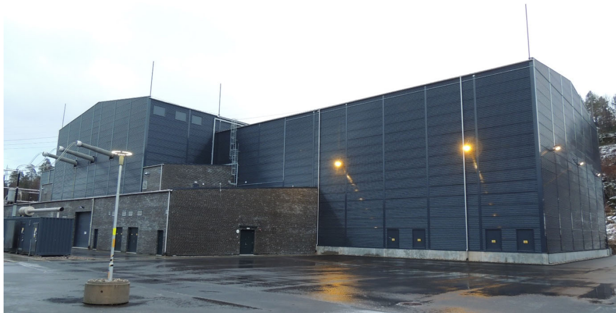
Figur 5: Strømretteranlegg for SK4 i Kristiansand transformatorstasjon
