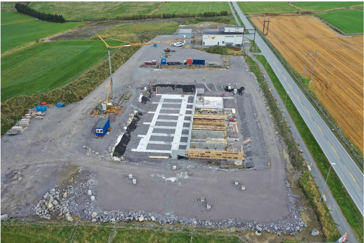
Figur 18 Nye Opstad transformatorstasjon, oversiktsbilde under utbygging
