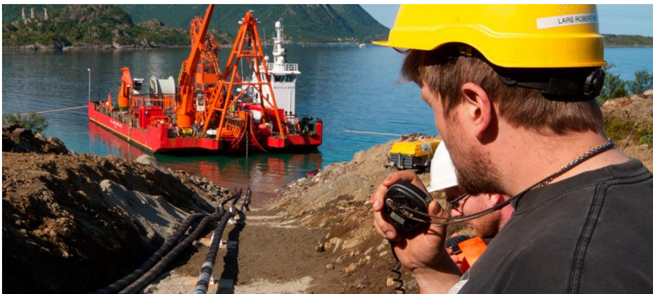
Figur 24 Landtak med grøft (kilde: Seløy Undervannsservice)
