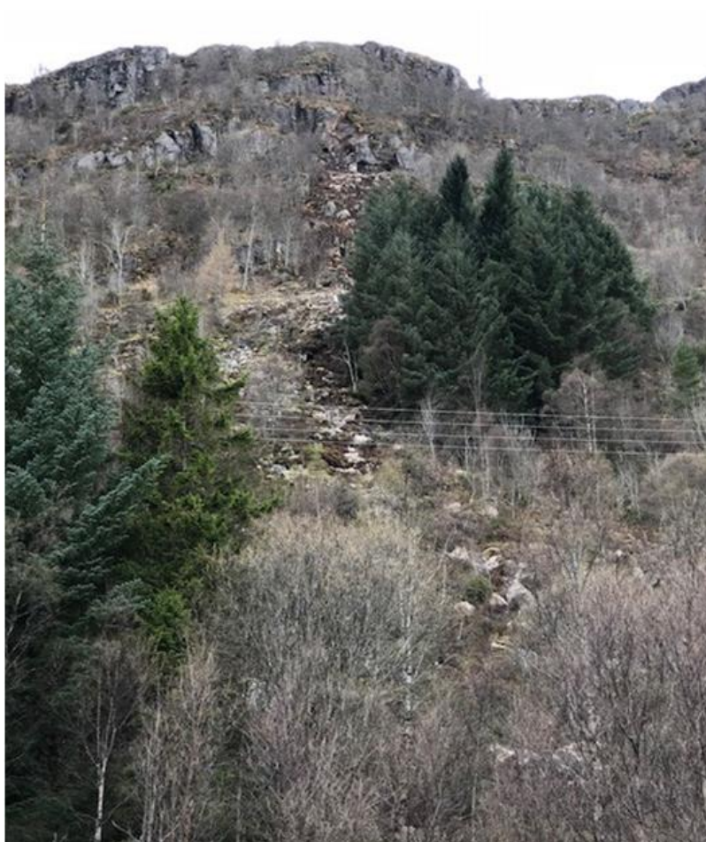
Figur 10 Foto (skredatlas) som viser skredet ned forbi kraftgaten og ned mot Brandalsvegen. Vi gikk ned langs skredet fra GPS punkt 024. Ved GPS punkt 026 ligger blokken som har nådd lengst ned i terrenget.
