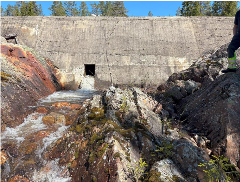
Figur 9 Tappeluke sett fra nedstrøms side
