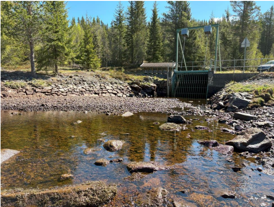
Figur 5 Bekkeinntak sett fra vest
