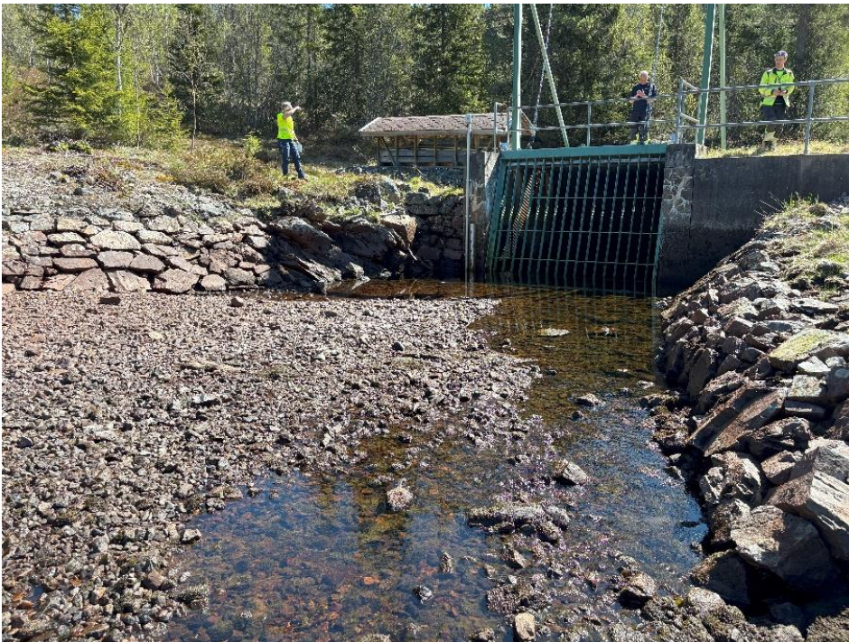
Figur 6 Bekkeinntak sett fra vest, nedtappet
