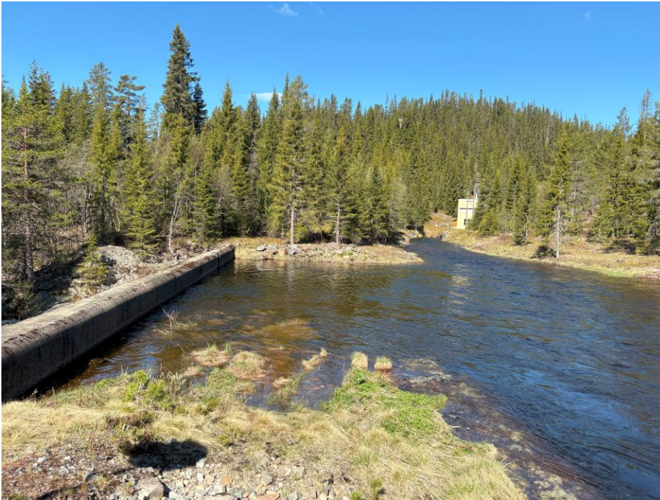
Figur 1 Inntakskulp sett fra øst ved vannføring 2,5 m 3 /s. Vannivå 1,15 m under topp terskel.
