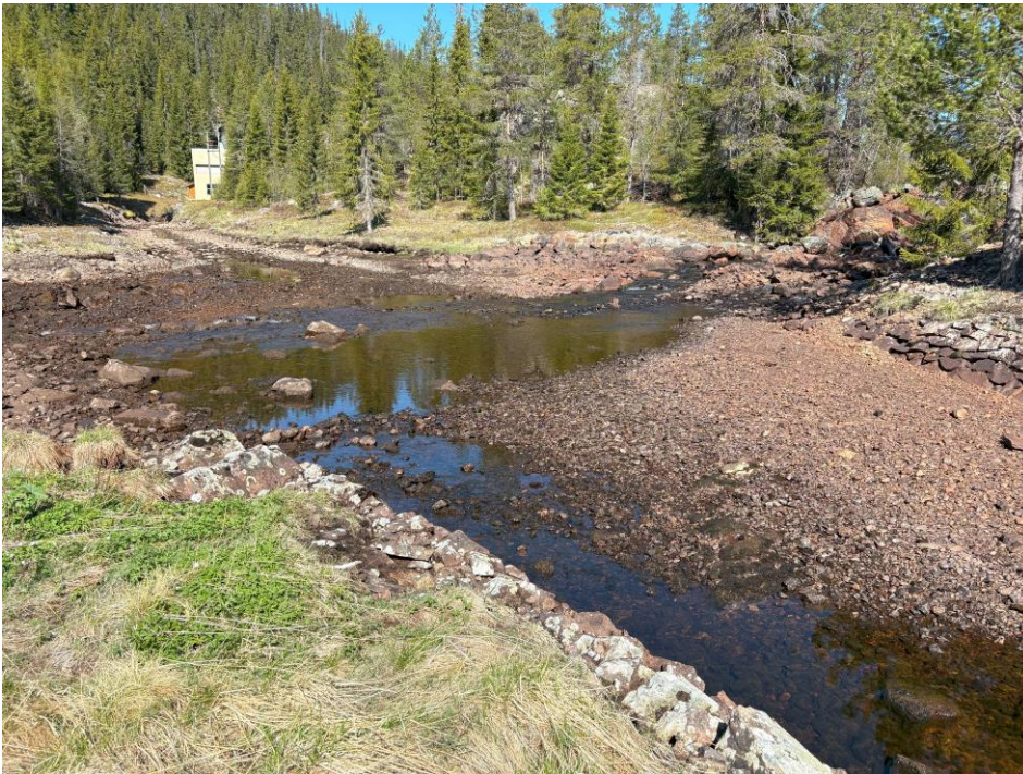
Figur 11 Inntakskulpen sett fra øst, nedtappet på lav vannstand
