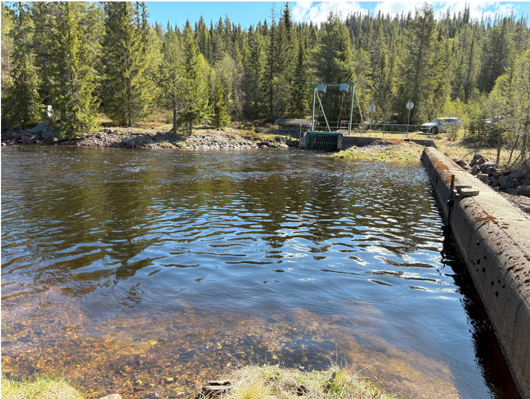
Figur 3 Bekkeinntaket Bjordøla sett fra vest. Bakerst i bildet er inntaket. Til høyre i bildet er terskelen som demmer opp inntakskulpen.
