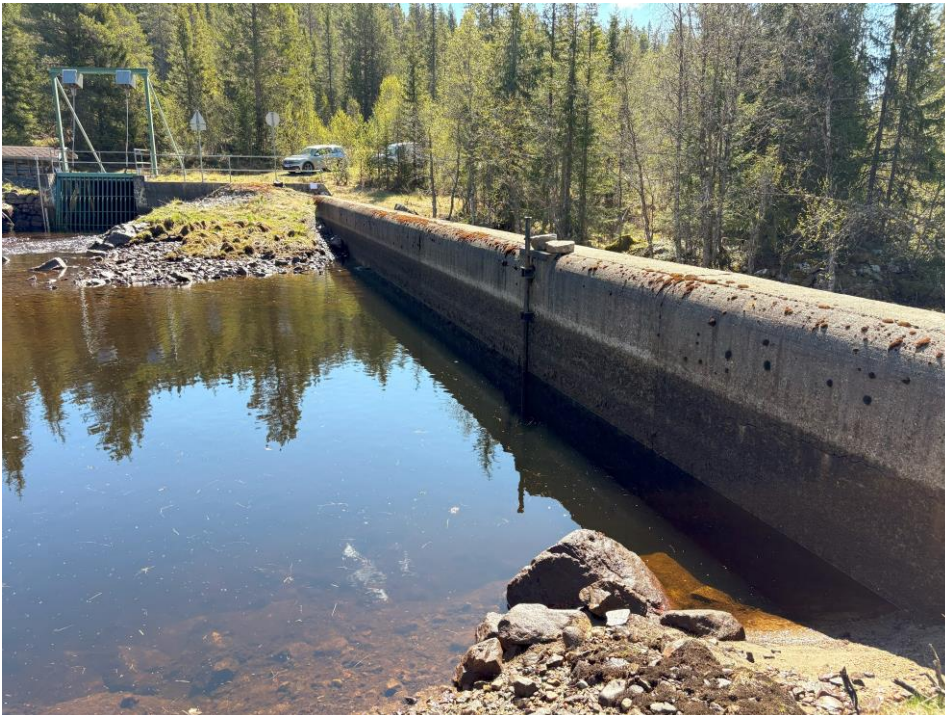
Figur 3 Inntaksdam sett fra vest
