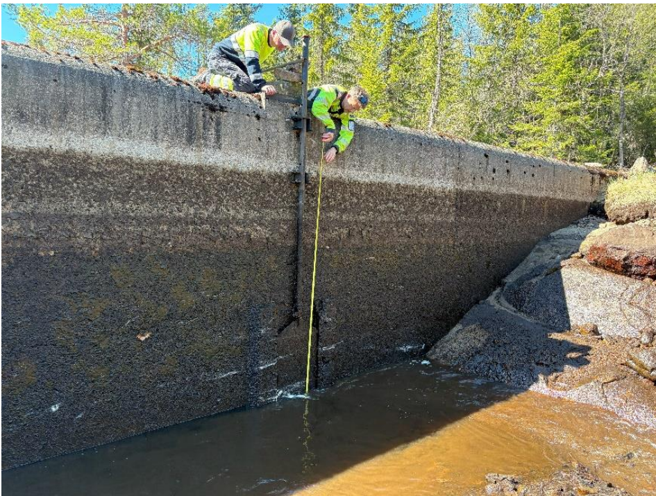
Figur 4 Inntaksdam sett fra oppstrøms side. Bunn tappeluken ca. 3,3 m under topp dam
