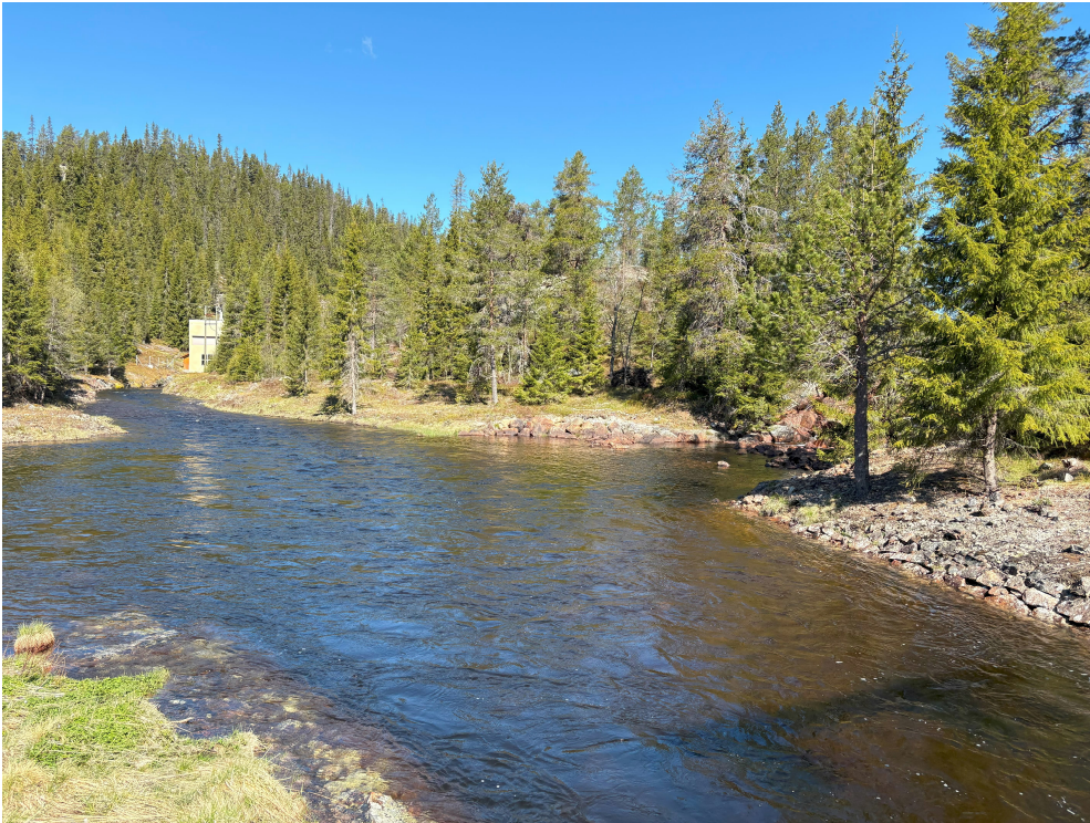
Figur 4 Innløpet til bekkeinntaket. Fra høyre ser man tilløpet fra elva Bjordøla. Til venstre ser man avløpet fra Bjordalen kraftverk som renner inn i inntakskulpen.
