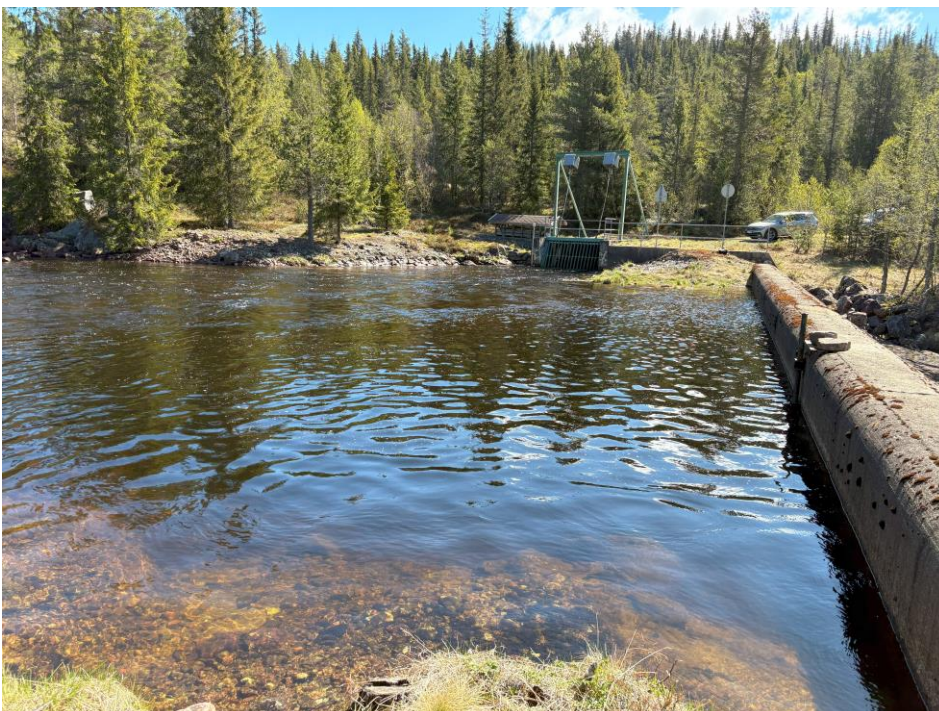
Figur 2 Bekkeinntak sett fra vest
