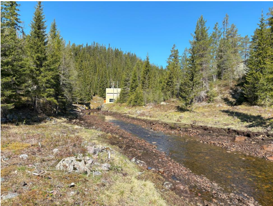
Figur 12 Utløp fra Bjordalen kraftstasjon ved lav vannstand.
