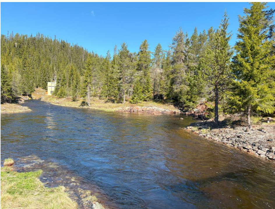
Figur 10 Inntakskulpen. Bak i bildet (høyre) ser man tilløpet fra elva Bjordøla. Til venstre er avløpet fra Bjordalen kraftverk som renner inn i inntakskulpen.
