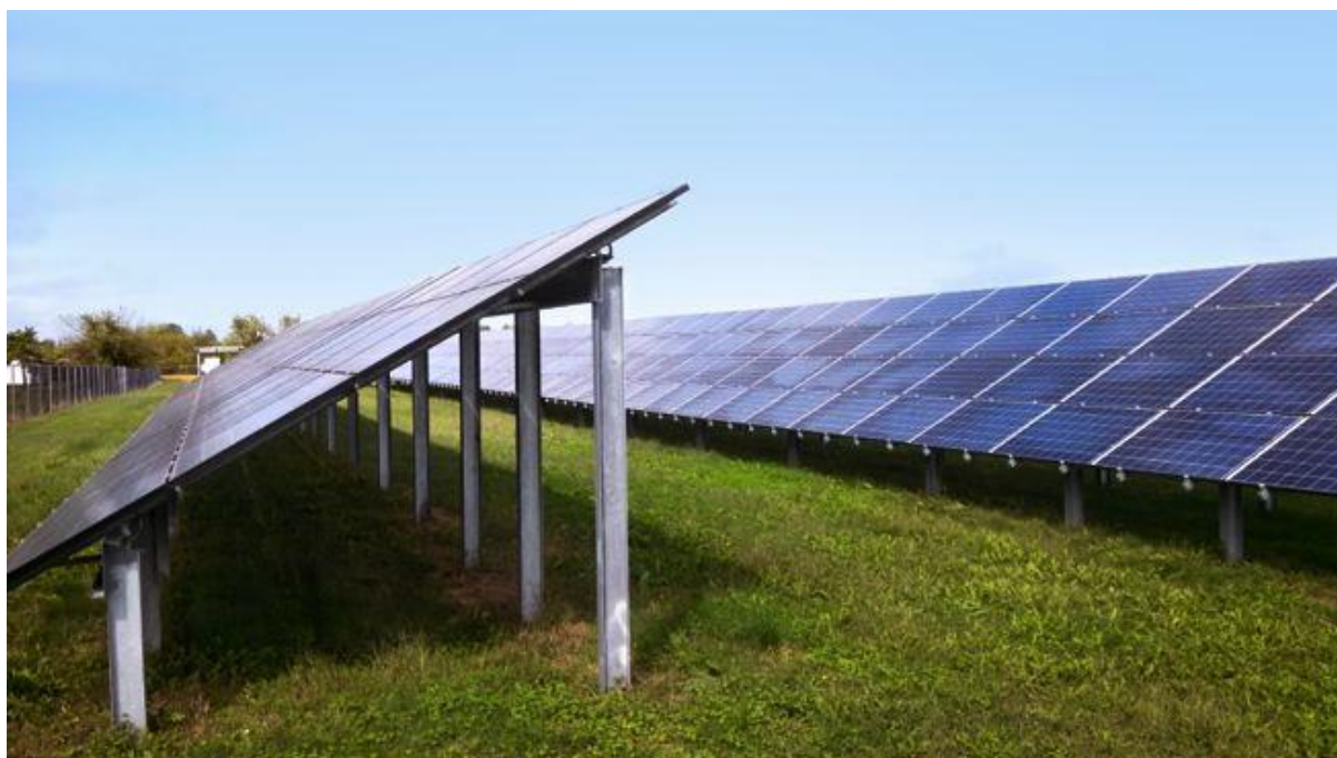
Figur 3-3: Fast-vinkel installasjonsløsning (foto: Willowbrook Solar).
