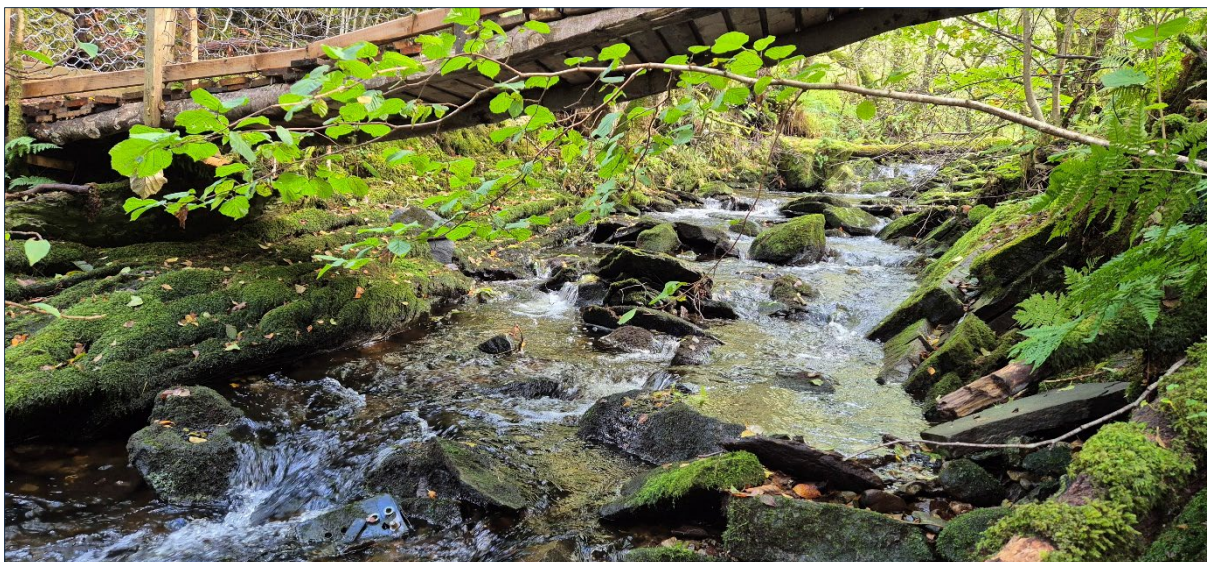
Figur 21: Gangbro sør for kritisk skråning 6 er fundamentert på fjell ved begge siden av elven. Foto: SGC.
