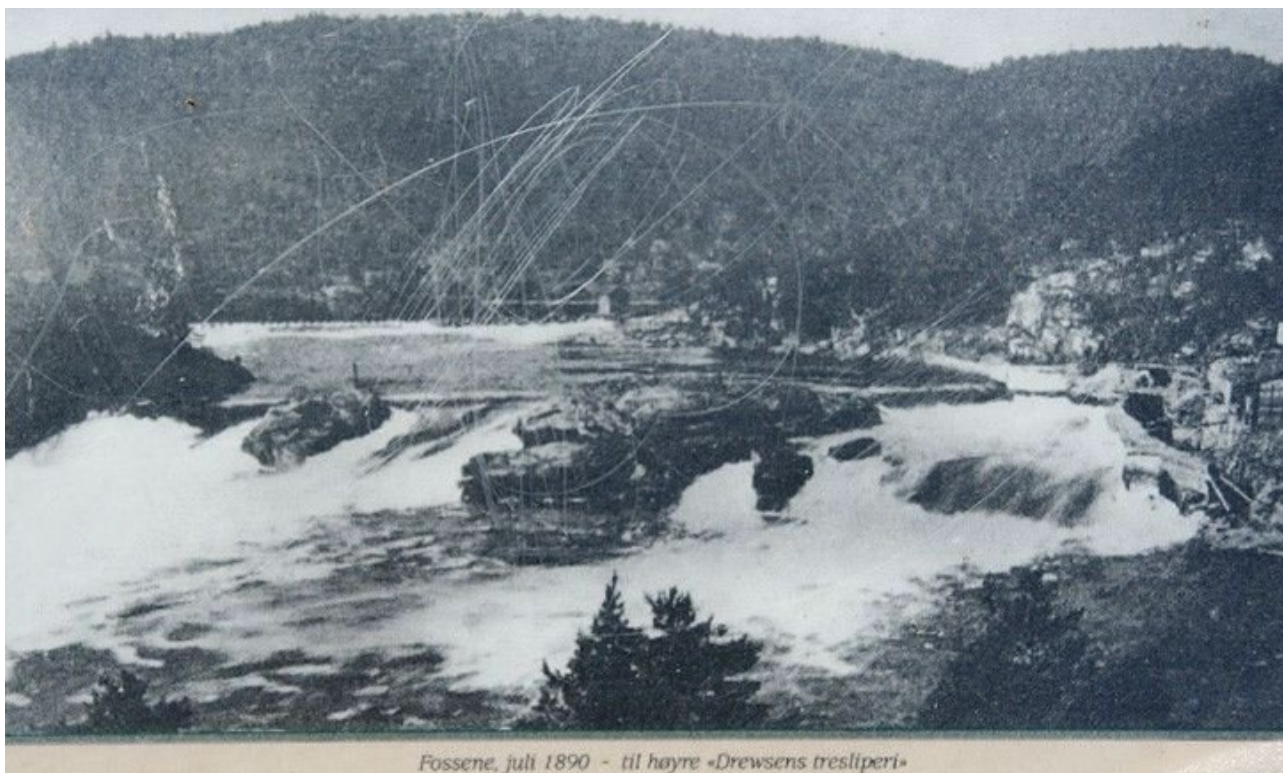
Figur 3. Nåledam over Skotfoss 1890. Denne stengte all oppvandring av fisk fra ca. 1872, og laks og sjørørret forsvant i nær hundre år fra de øvre deler av vassdraget. Et målrettet arbeid for å reetablere laks og sjørørret i øvre deler av vassdraget startet først i 1980 (Carm and Langkaas 1993). Kilde: Dag Natedal.
