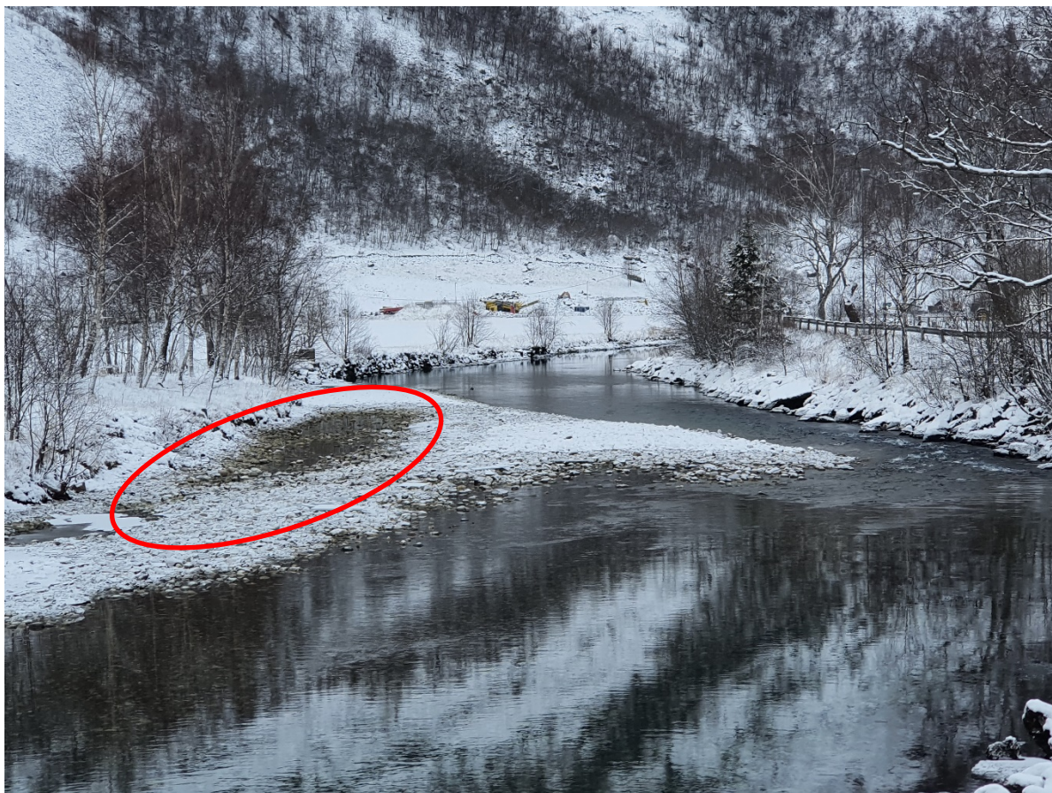
Figur 9. Utsatt areal ved Flåm samfunnshus med stor fare for stranding av ungfisk og insektlarver ved raske vannføringsreduksjoner.
