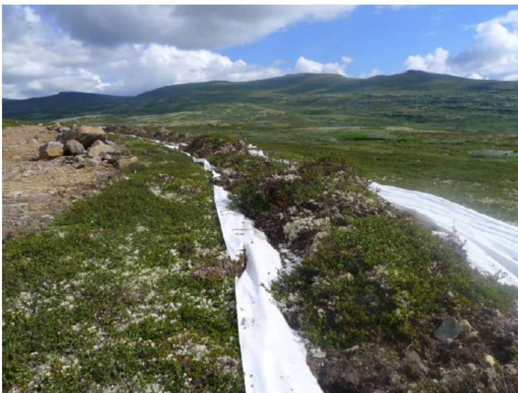
Figur 0-2: Mellomlagring av toppmasser og vegetasjon på duk. Illustrasjonsfoto hentet fra Hagen (2012).
