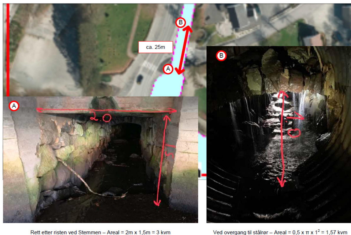
Figur 3-3 Overgangen til stålrør inne i kulverten fra utløpet til Stemmen.
