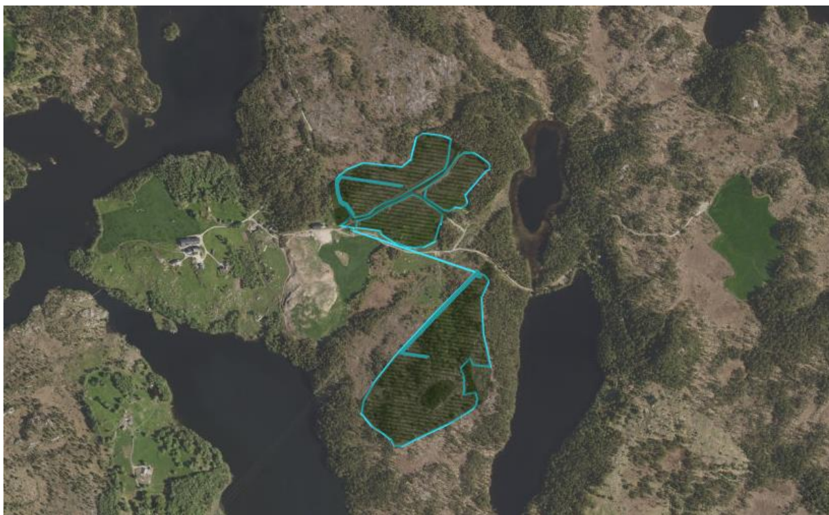
Figur 25 Flyfoto over Nesse solkraftverk på hver side av veien midt i bildet. (norgeskart.no)
