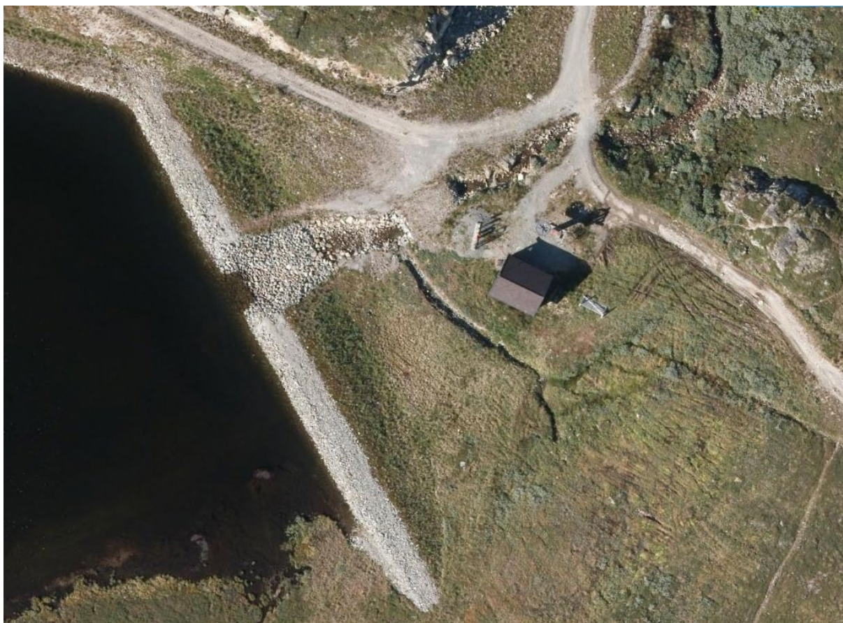
Figur 1-2 Oversiktsbilde fra damstedet ved utløpet av Tottetjern. (Kilde: Finn kart)
