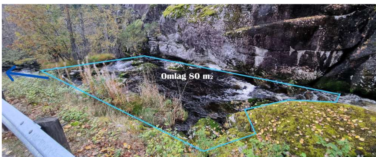
Figur 19: Lokalisering av inntaket omlag kôte 320, sett nedstrøms.
