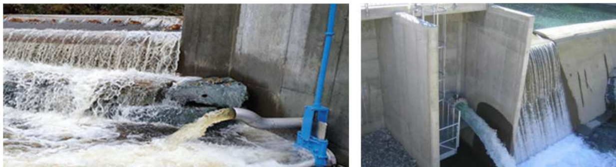
Figur 92: Eksempel på arrangement for minstevassføring.
