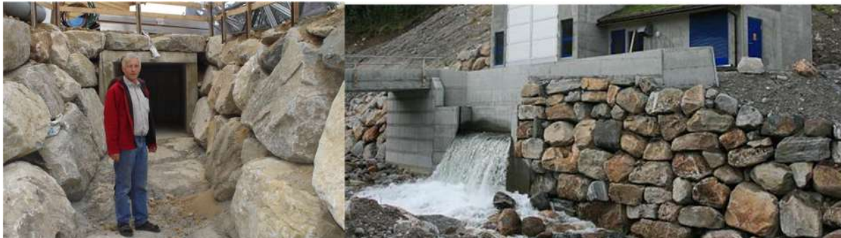
Figur 96: Peltonutløp – utan «vasslås» – og med, der terskelen stenger lyden.
