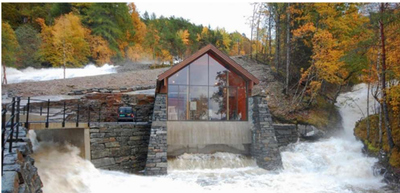
Figur 99: Peltonutløp med «vasslås» der terskelen stenger lyden.
