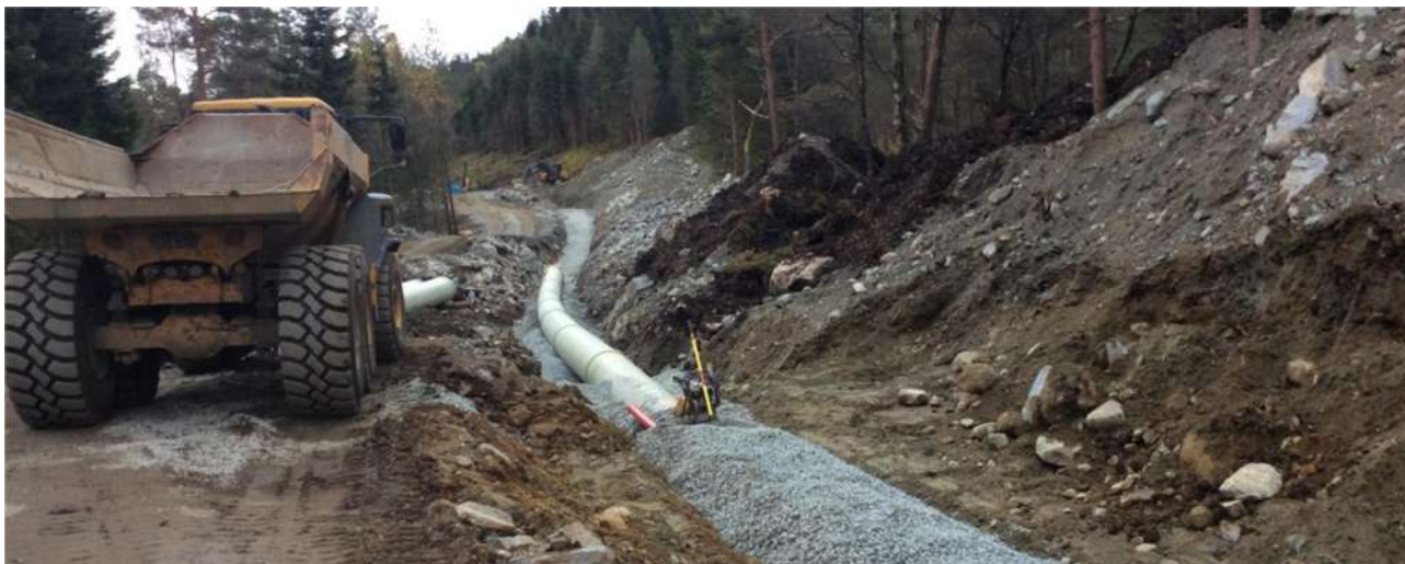
Figur 26: Utdrag frå rettleiar for framføring av GRP-rørgate.
