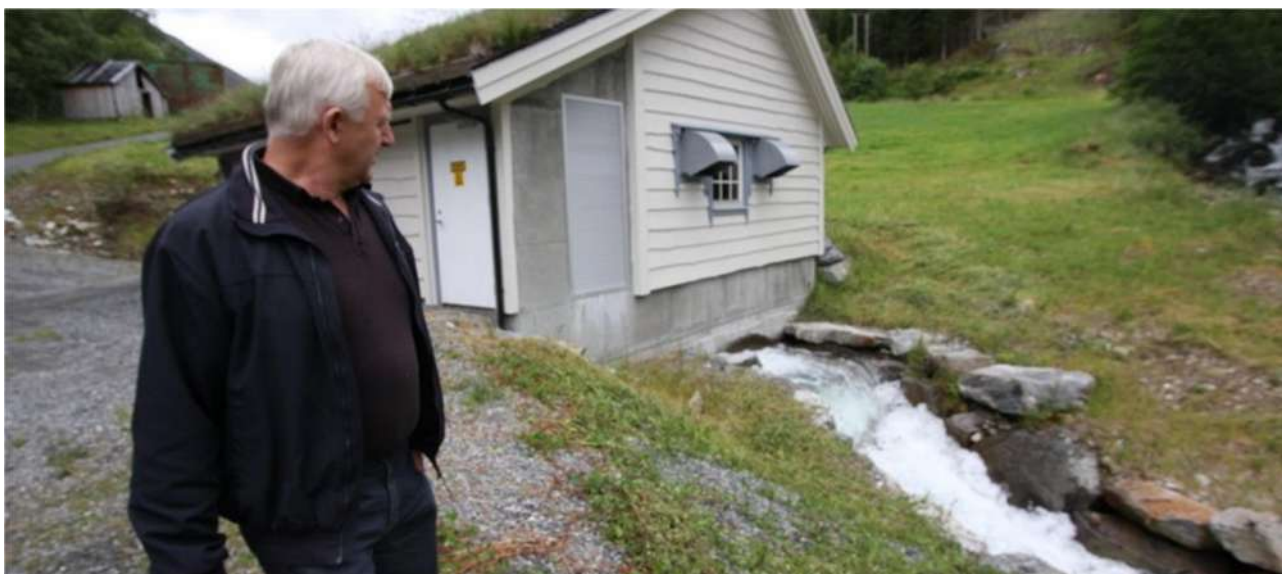
Figur 98: Peltonutløp med «vasslås» der terskelen stenger lyden.
