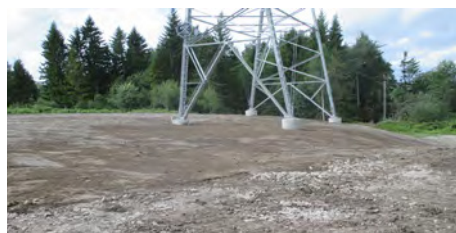
Figur 28: Mastepunkt som er tilbakeført som en stor glatt flate. Her burde flaten vært brutt opp ved å lagd forhøyninger og forsenkninger. I tillegg burde det vært plassert ut vegetasjonstuer for at naturlig veetasjon raskere kan reetableres.
