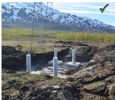
Figur 17: Godt eksempel på at vegetasjonslaget er tatt ivarepå, for bruk til istandsetting.
