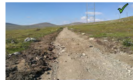
Figur 32: Godt tilrettelagt kjørespor der vegetasjonsmasser er lagt til side for istandsettingem
