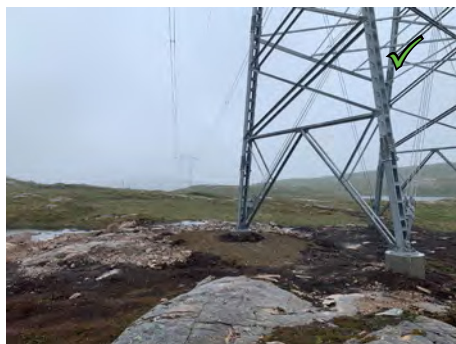
Figur 22: Her er sprengsteinsblokk fjernet fra overflaten.
