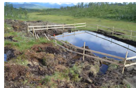
Figur 39: Etabler sedimentsjonsbasseng for håndtering av vann fra byggegrøp for mastepunkt. Bassenget fylles igjen etter bruk..
