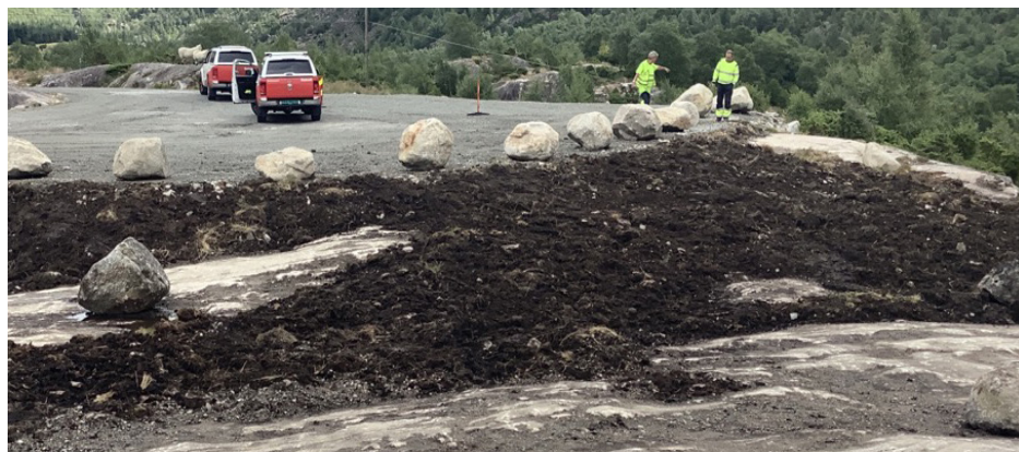
Figur 36: Eksempel på ferdigstilt hjelpeanlegg, istandsatt etter Landbruksdirektoratets veileder.
