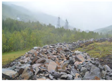
Figur 43: Motfylling for å forhindre at masser renner utenfor deponiområdet.
