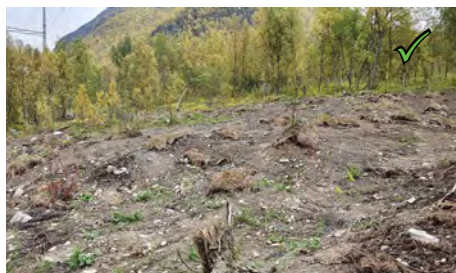
Figur 27: Istsandsatt trommelplass der tuer med vegetasjon er plassert ut. Dette gjør at revegeteringen går raskere.
