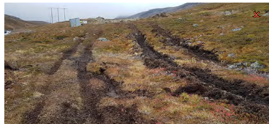
Figur 8: Når det etableres et nytt kjørespor, skal dette benyttes. Entreprenør skal terrengforsterke fremfor å etablere parallele spor.
