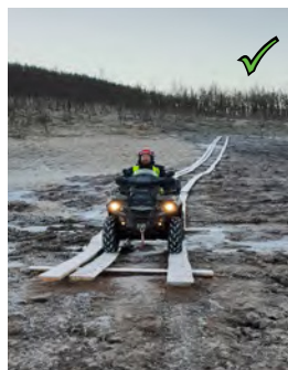
Figur 10: Eksempel på etablert terrengforsterkning over bløte partier.
