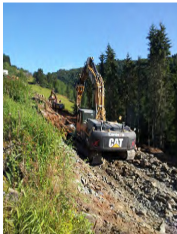
Figur 34: Opprusting av landbruksveg med stedege masser.
