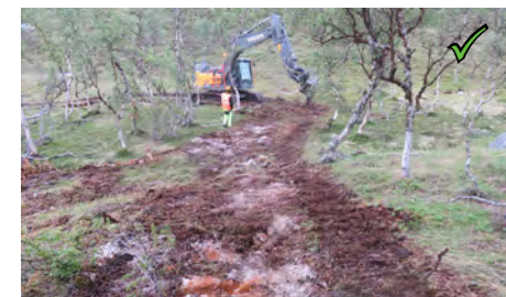
Figur 31: Ved uttransportering av maskiner og utstyr, skal kjørespor legges i gjenn og pusses. Gjennlagte spor skal ikke på nytt benyttes uten avklaring med Statnett
