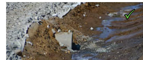
Figur 7: Ved etablering av tilkomster skal entreprenør sikre at eksisterende vannveier/vannsig ikke endrer løp. Dette kan enten gjøres ved å legge rør under, eller lede vann over en erosjonssikret del av kjøreflaten.
