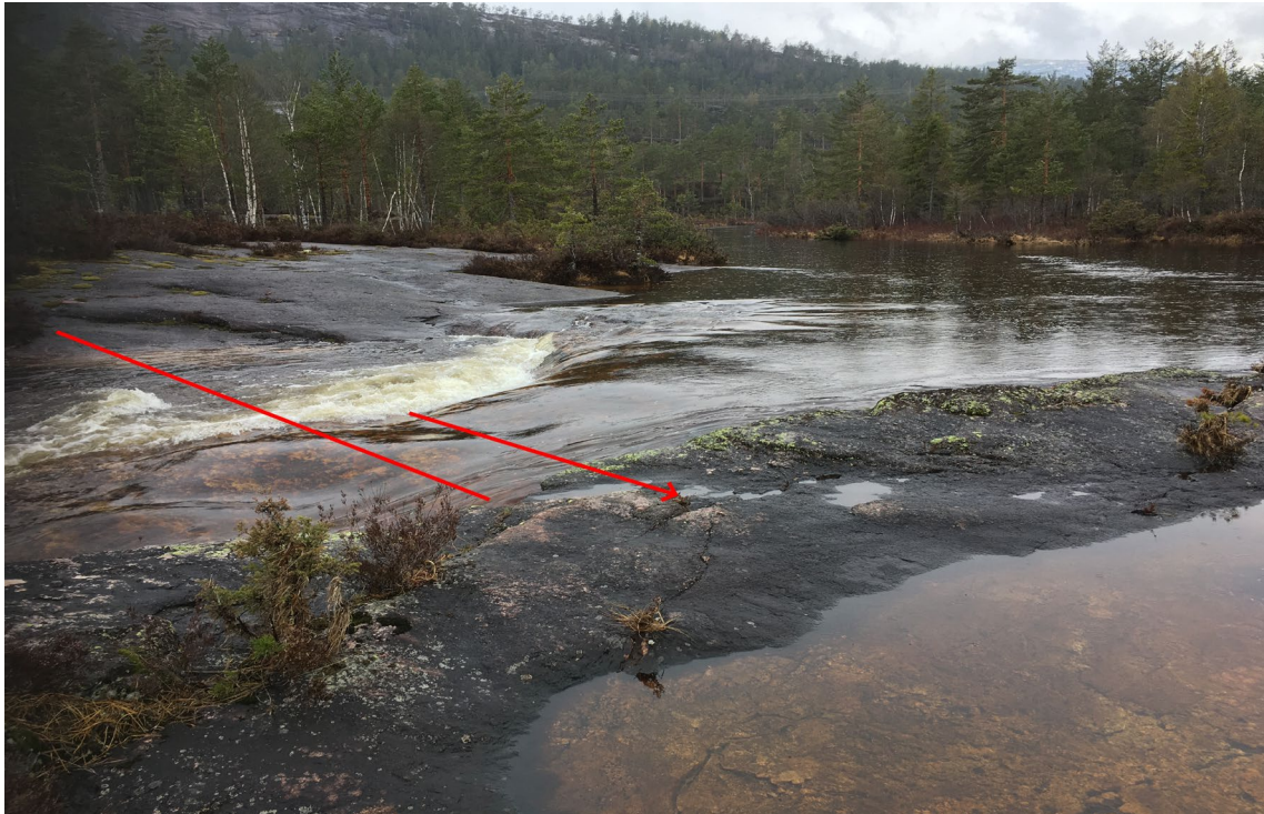
Fig 5: Inntaksterskel har overløp under nivået i tjernet ovenfor (Foto: Småkraftkonsult, 11.05.2023)
