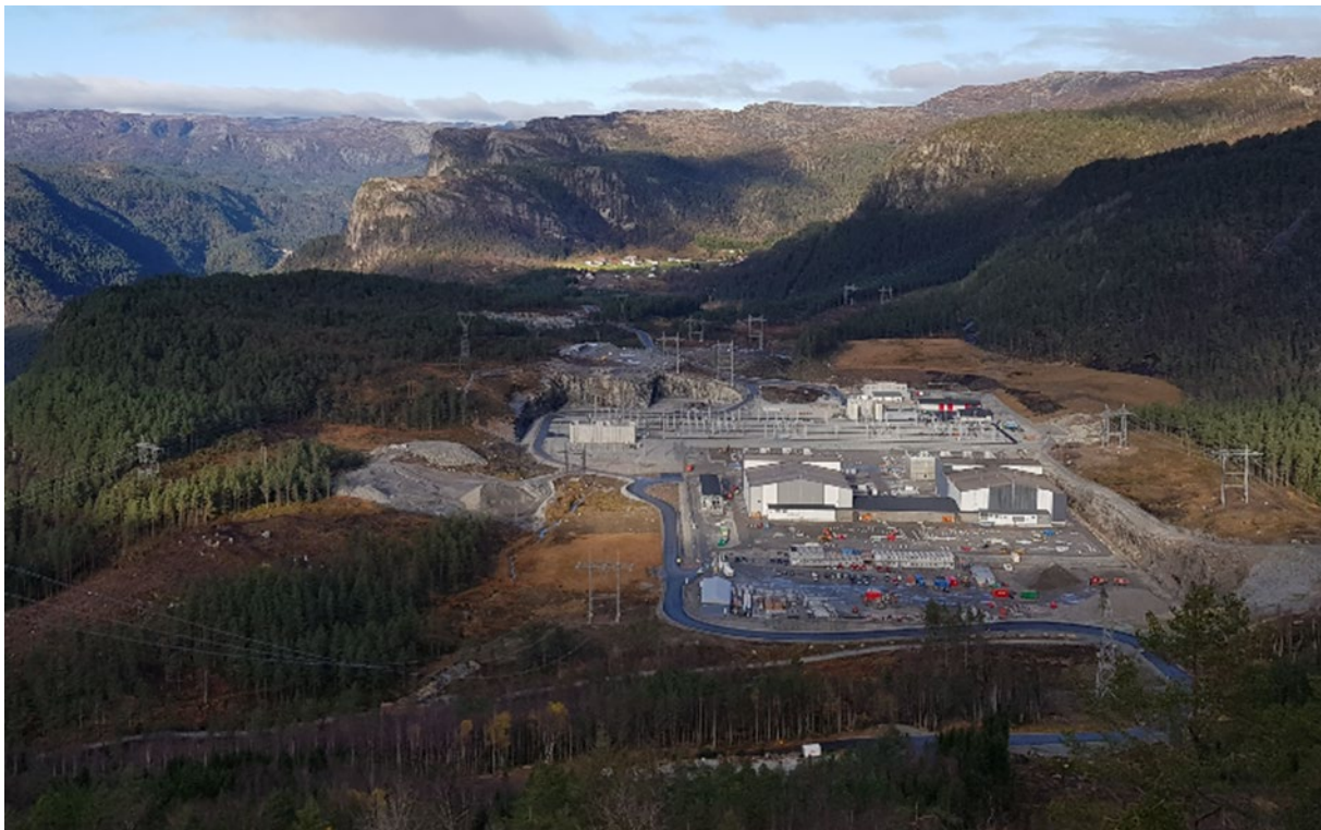
Figur 16 Ertsmyra transformatorstasjon, NordLink omformerstasjon 1400 MW
