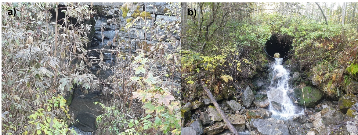
Bilde v3. På tur ned mot Driva passerer Stor-Vinnu først under gang- og sykkelveien med steinsatt elvebunn (a), deretter rv. 70 gjennom kulvert (b). Foto: Eva M. Ulvan, NINA.
