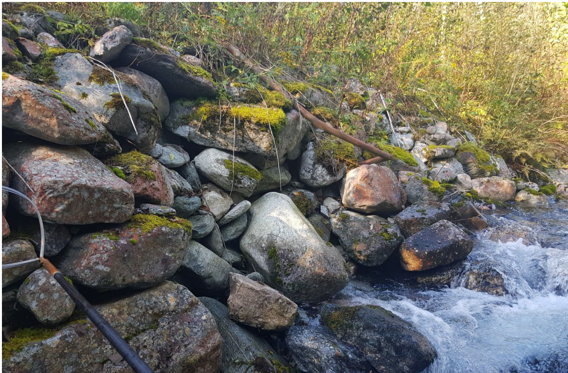
Bilde s6. Steinforbygninger og rester etter et gammelt vannrør ovenfor riksveg 70. Foto: Knut A. E. Bækkelie, NINA.
