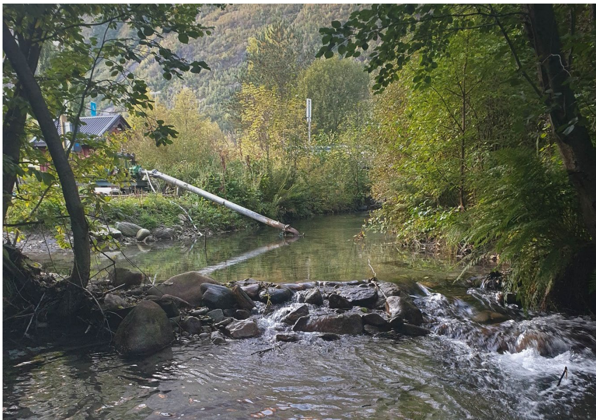
Bilde 13. Terskel nedenfor brua ved barneskolen som trolig er bygd for å sikre stabil tilførsel til et vanninntak. Foto: Torgeir B. Havn, NINA.
