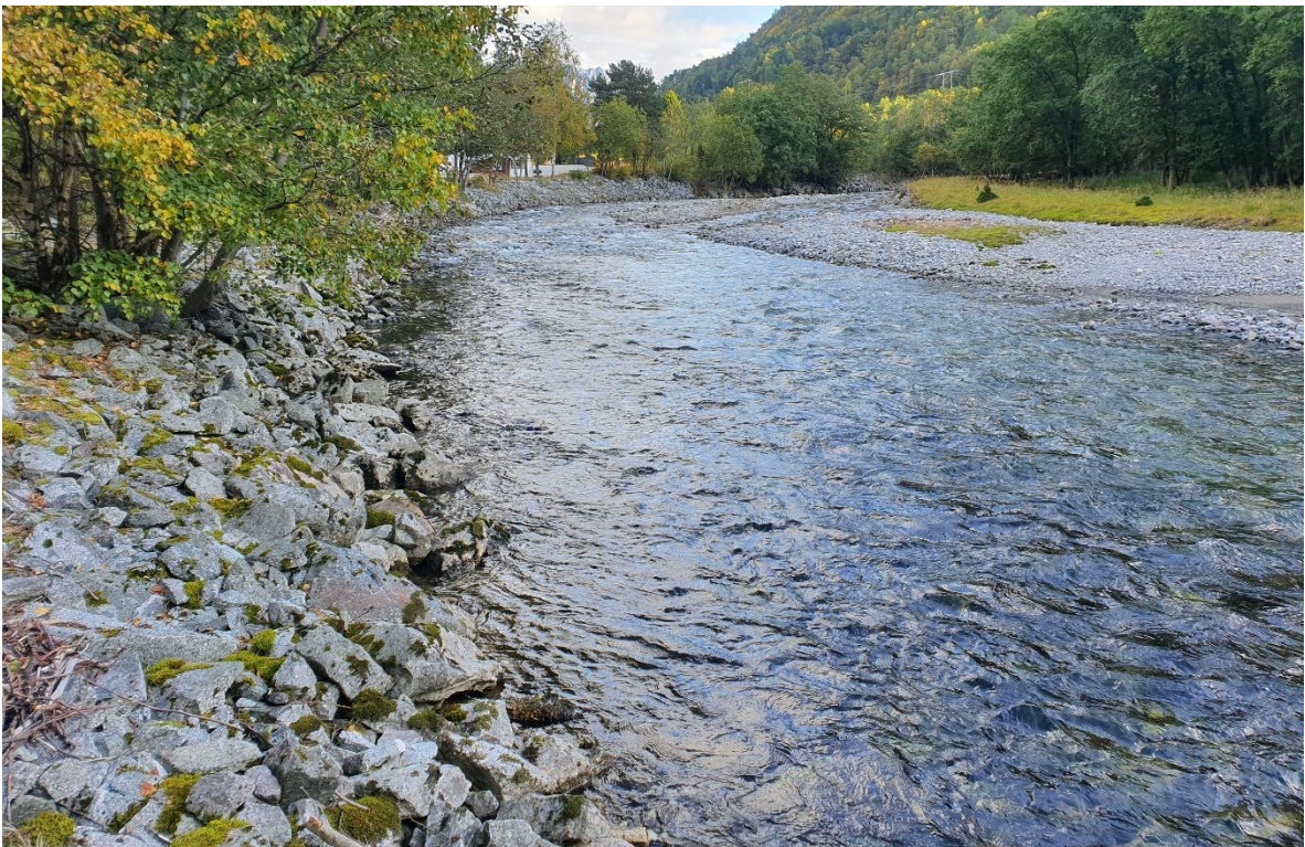
Bilde g2. Flomvern i øvre del av Grøa. Foto: Torgeir B. Havn
