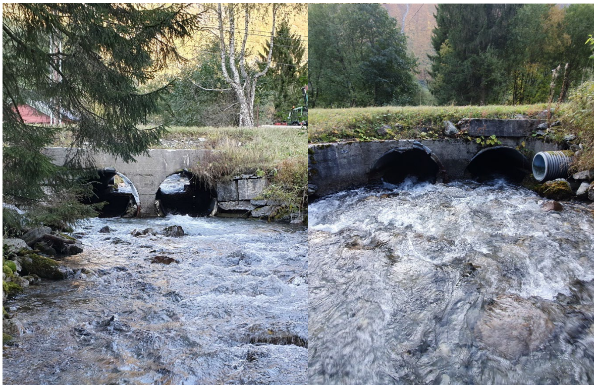
Bilde s4. Over og underside av kulvertene under riksveg 70. Foto: Torgeir B. Havn, NINA.
