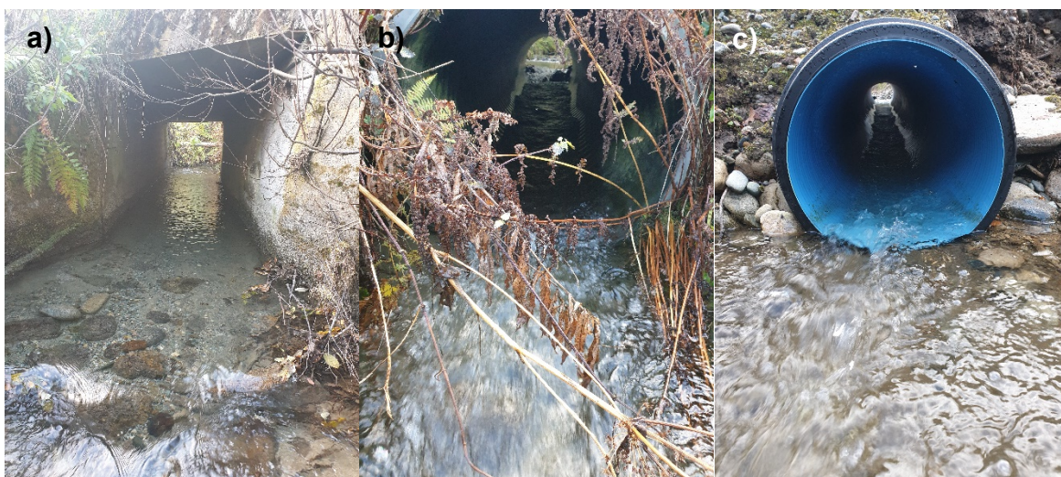
Bilde h7. Veibru på Hovenveien (a) og eksempler på rør under gang-/og kjørebrurer (b og c) oppover i sidebekken til Hareima. Foto: Eva M. Ulvan, NINA.
