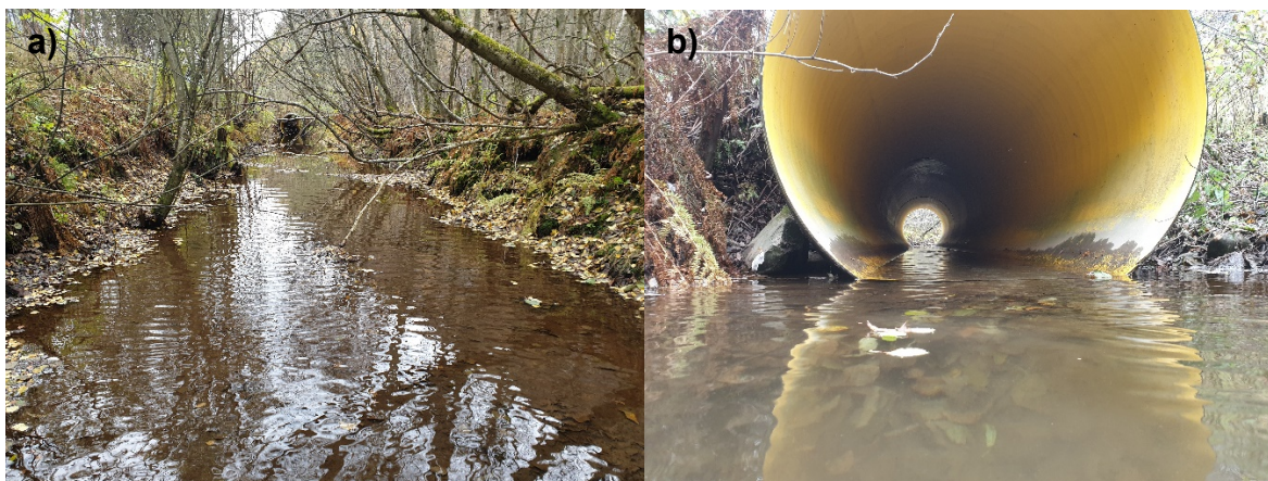
Bilde b5. Sidegreina av Breiåa som kommer fra øst er stedvis utrettet og stilleflytende (a) og går gjennom kulvert under fv. 6138 (b). Foto: Eva M. Ulvan, NINA.
