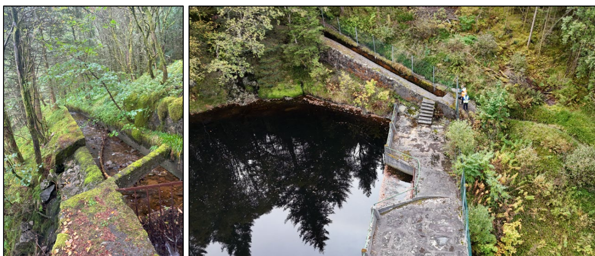
Figur 4: Omløpskanal ved dam Skredderdalen
