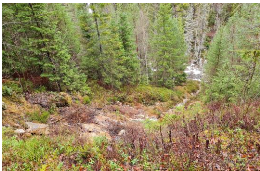
Figur 2 Utrast skråning ved siden av traktorvegen
