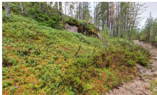
Figur 3 Overliggende vegetasjon og fjell på andre sida av utrast skråning
