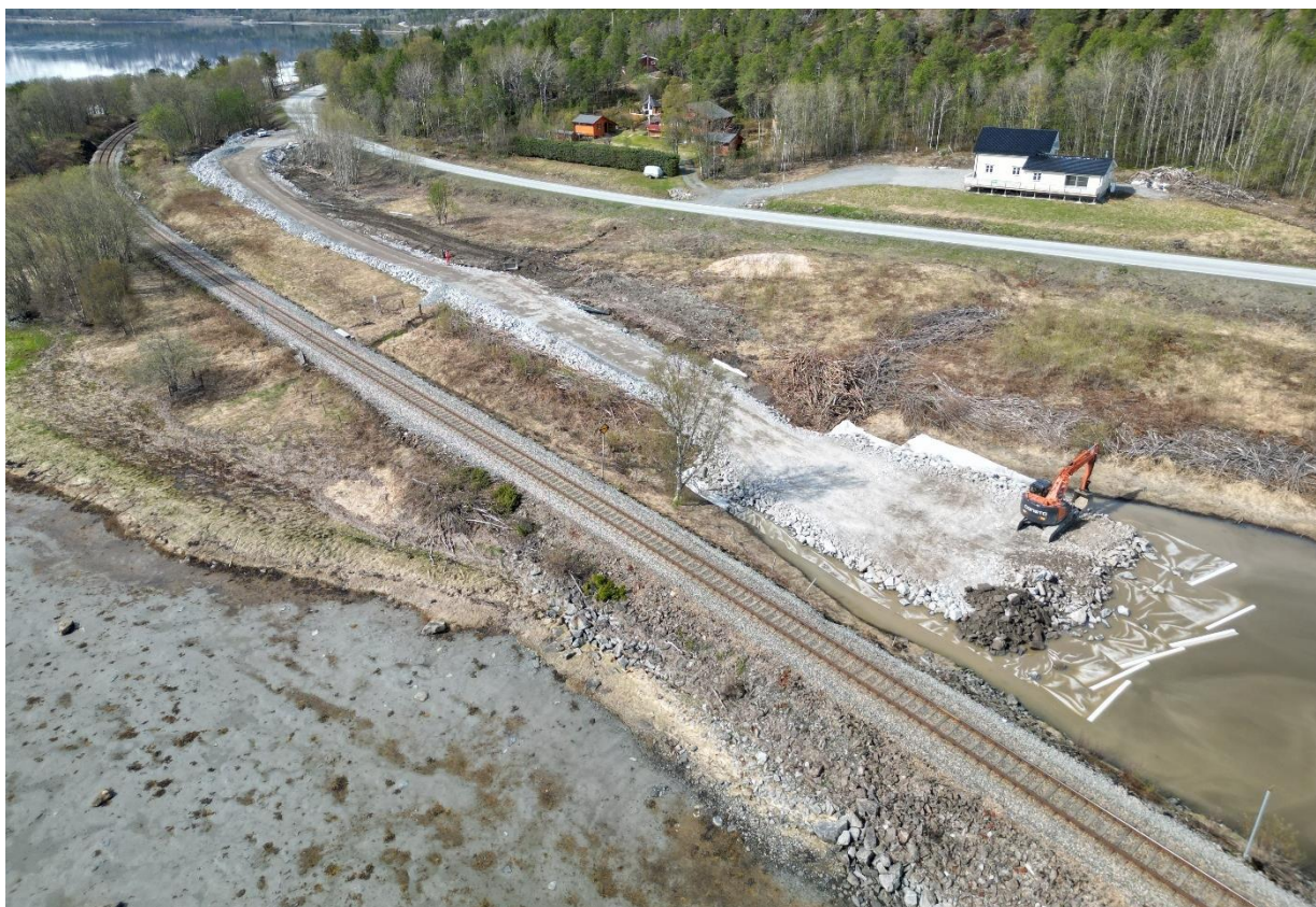
Foto 3: Anleggsveg og etablering av første lag i vegfyllingen (foto H.Lissman 2024.05.14)
