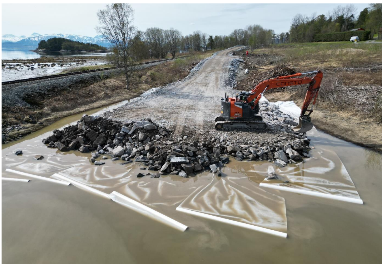
Foto 4: Utlegging av første lag i vegfyllingen (foto H.Lissman 2024.05.14)
