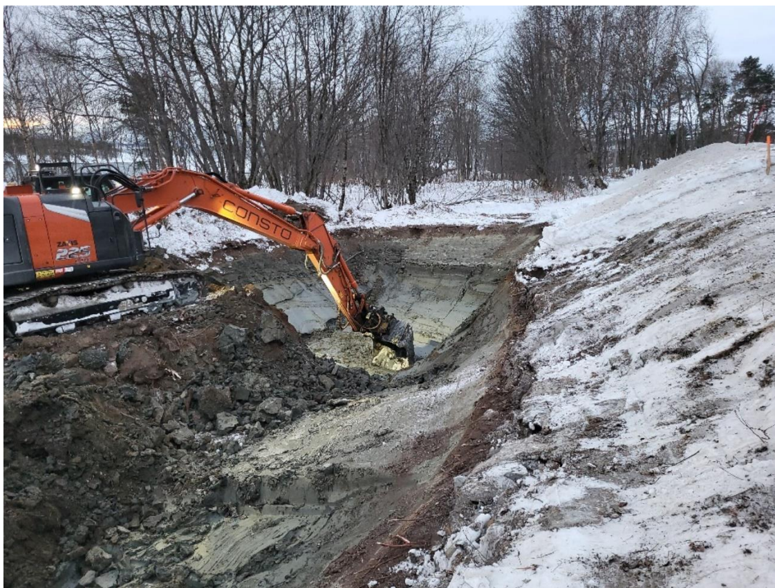
Foto 1: Masseutskifting avkjørsel ved profil ca. 2450–2480 (foto H.Lissman 2023.12.13)
