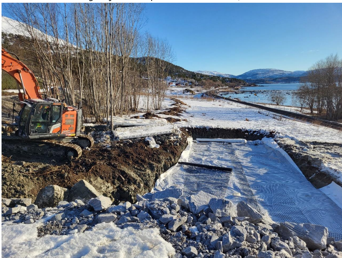
Foto 2: Etablering av anleggsveg ved profil ca. 2510 (foto H.Lissman 2024.03.13)
