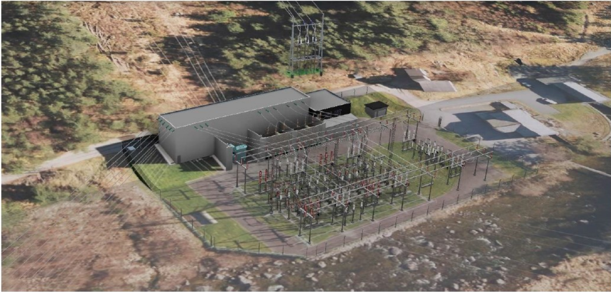
Figur 26: Dalen transformatorstasjon med nytt koblingsfelt, sett fra sør. Nytt innstrekkestativ er plassert nord for stasjonen. Kilde: Lyse Elnett 2019.
