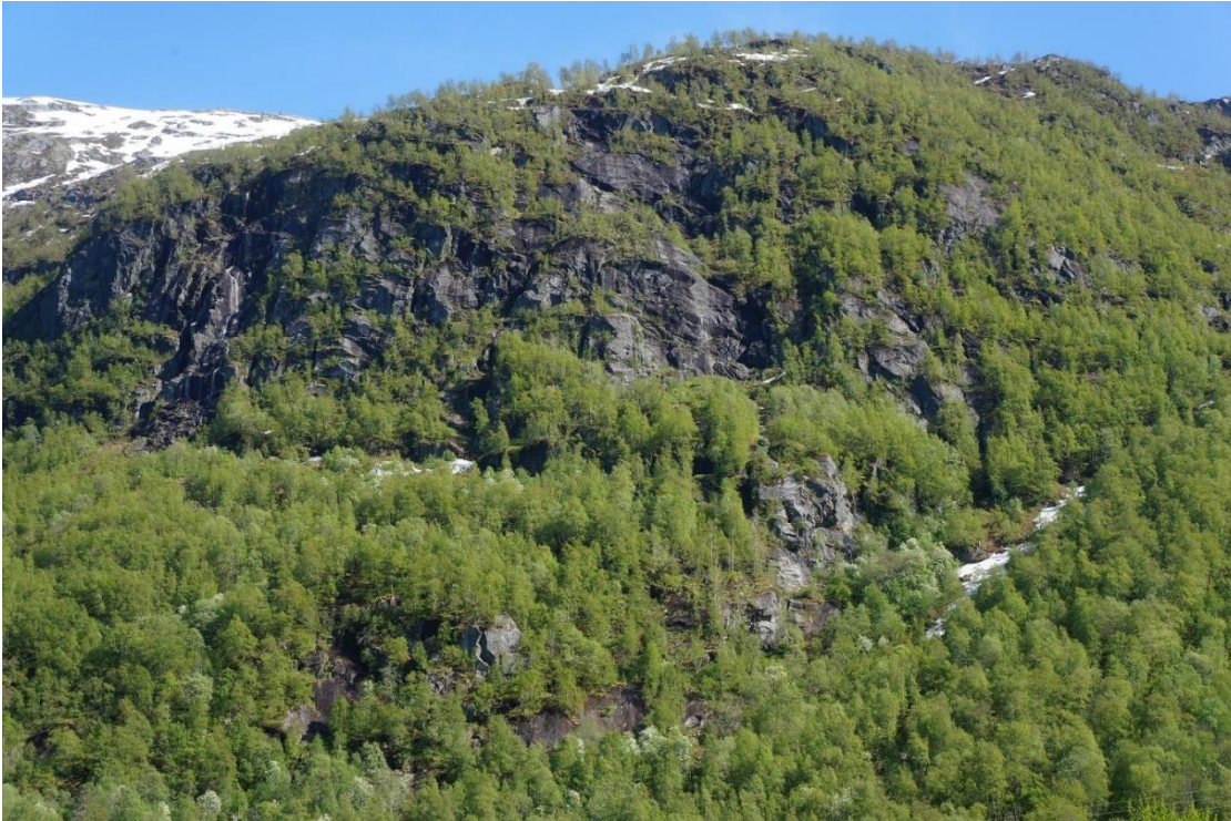
Figur 3-18. Store områder øst for Gravegjel som er potensielle kildeområder for steinsprang.
