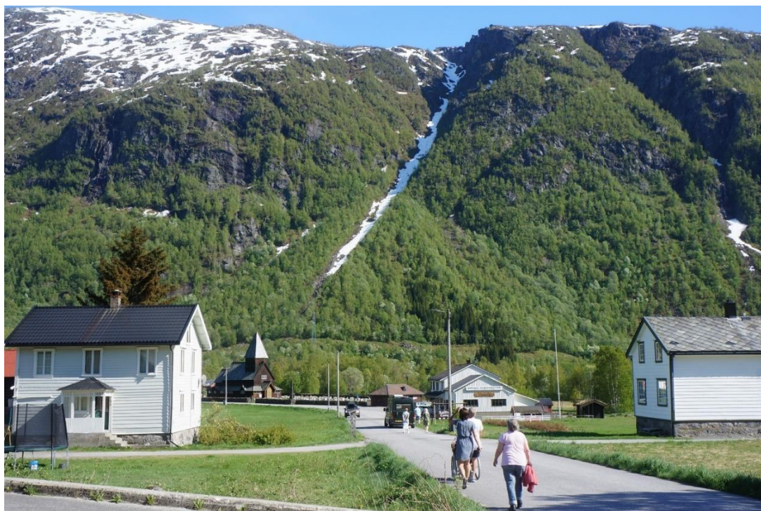
Figur 3-13. Sikt mot Gravegjel og vifta nedenfor. Mot venstre i bilde er det bratte skrentpartier med potensielle løsneområder for steinsprang.
