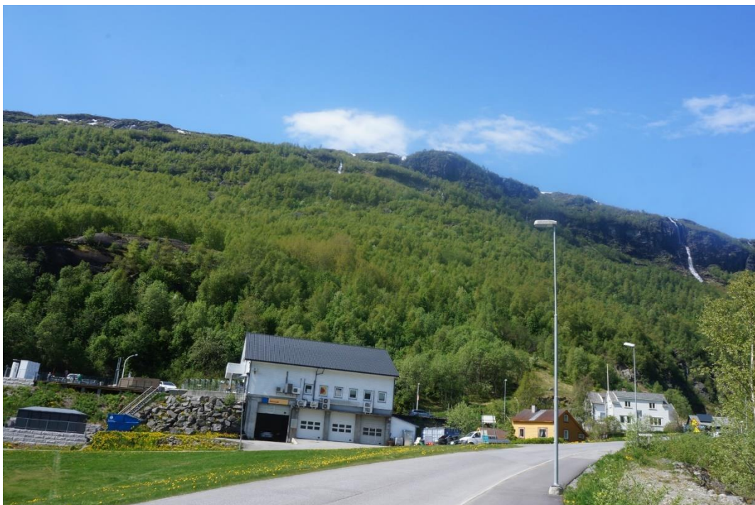
Figur 3-9. Bensinstasjon ved Seim med noen lokale brattskrenter over, lite utfallspotensiale er observert fra disse småskrentene.
