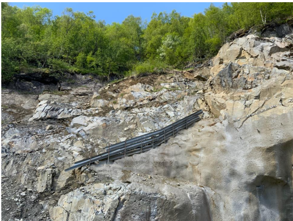
Figur 3-11. Sikring ovenfor kraftverket. Menneskeskapte skjæringer er ikke inkludert i skredfarevurderingen. Det er likevel vurdert at det er potensielle løснеområder for jordskred ovenfor skjæringen.
