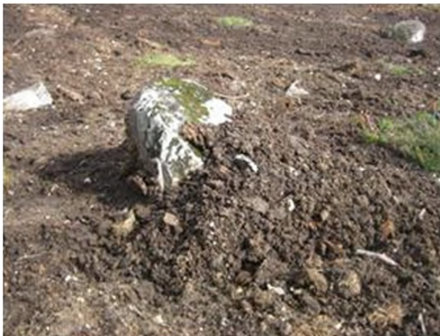
Figur 3-2. Eksempel på stein som er plassert i riktig dybde med den patinerte overflaten opp. Dette eksempelet viser riktignok et område med en vesentlig større mektighet i massene enn det som forekommer ved Prestesteinsvatnet.
