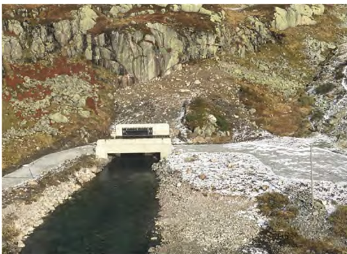
Figur 3-4. Eksempel på tunnelutløp med støpt kulvert i forlengelse av tunnelen. Eksempelene er fra Ståvatn (t.v.) og Kjølavatn (t.h.).
