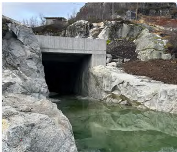
Figur 3-4. Eksempel på tunnelutløp med støpt kulvert i forlengelse av tunnelen. Eksempelene er fra Ståvatn (t.v.) og Kjølavatn (t.h.).
