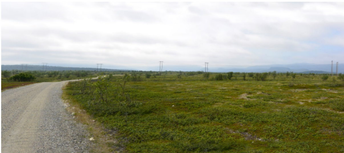
Figur 5.7-4: Dagens 132 kV- og 66 kV-ledninger, som begge går gjennom Stabbursdalen landskapsvernområde, fotografert fra veien inn til nasjonalparken. Kilde: Statnetts tilleggssøknad juni 2023.
