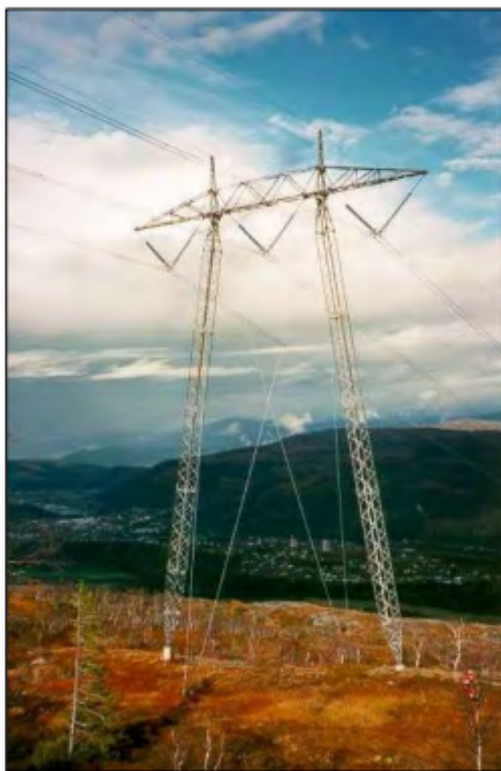
Figur 1-2: illustrasjon av aktuelle mastetyper. Til venstre selvbærende portalmast i stål, til høyre utvendig bardunert mast (M-mast). Kilde: Statnetts søknad.
