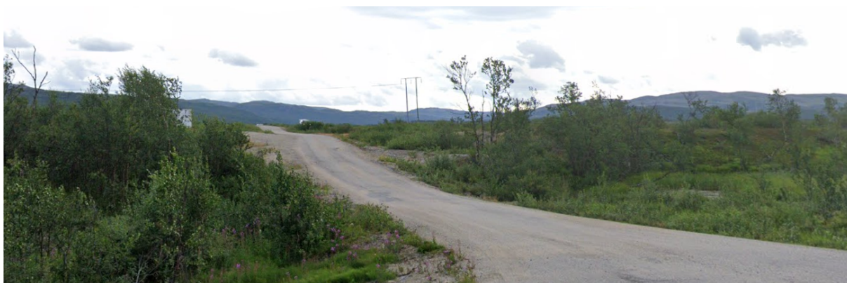
Figur 5.7-14: Dagens 132 kV kraftledning sett fra nærmeste punkt på fylkesveien i Adamsfjorddalen. Ny 420 kV ledning vil gå bortenfor og parallelt med denne. Kilde: Google Street View 2024.
