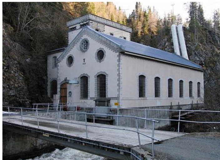
Bilde: Skjenaldfoss kraftverk
