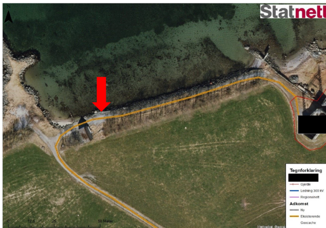
Figur 3 Kritisk sted på vegen til muffeanlegget, der det er støpt en betongplate mellom nauset og vannkanten.
