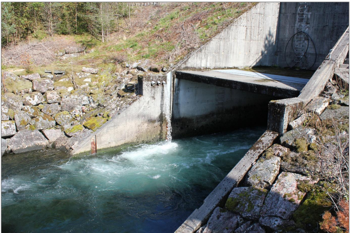
Utløpet fra Evinys kraftverk ved Hellandsfoss. Her er det ingen sperre for fisk, som da fritt kan vandre inn i kraftverket. Foto: Alv Arne Lyse, NJFF.
