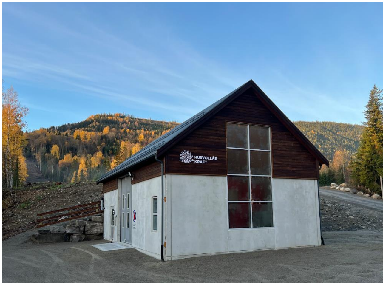
Figur 15 Typisk Pelton kraftstasjonsbygning (bilde fra Husvollåe kraftverk)
