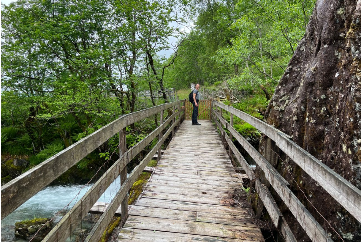
Bilde 9 Gangbro over Hundsåna oppstrøms fossefall
