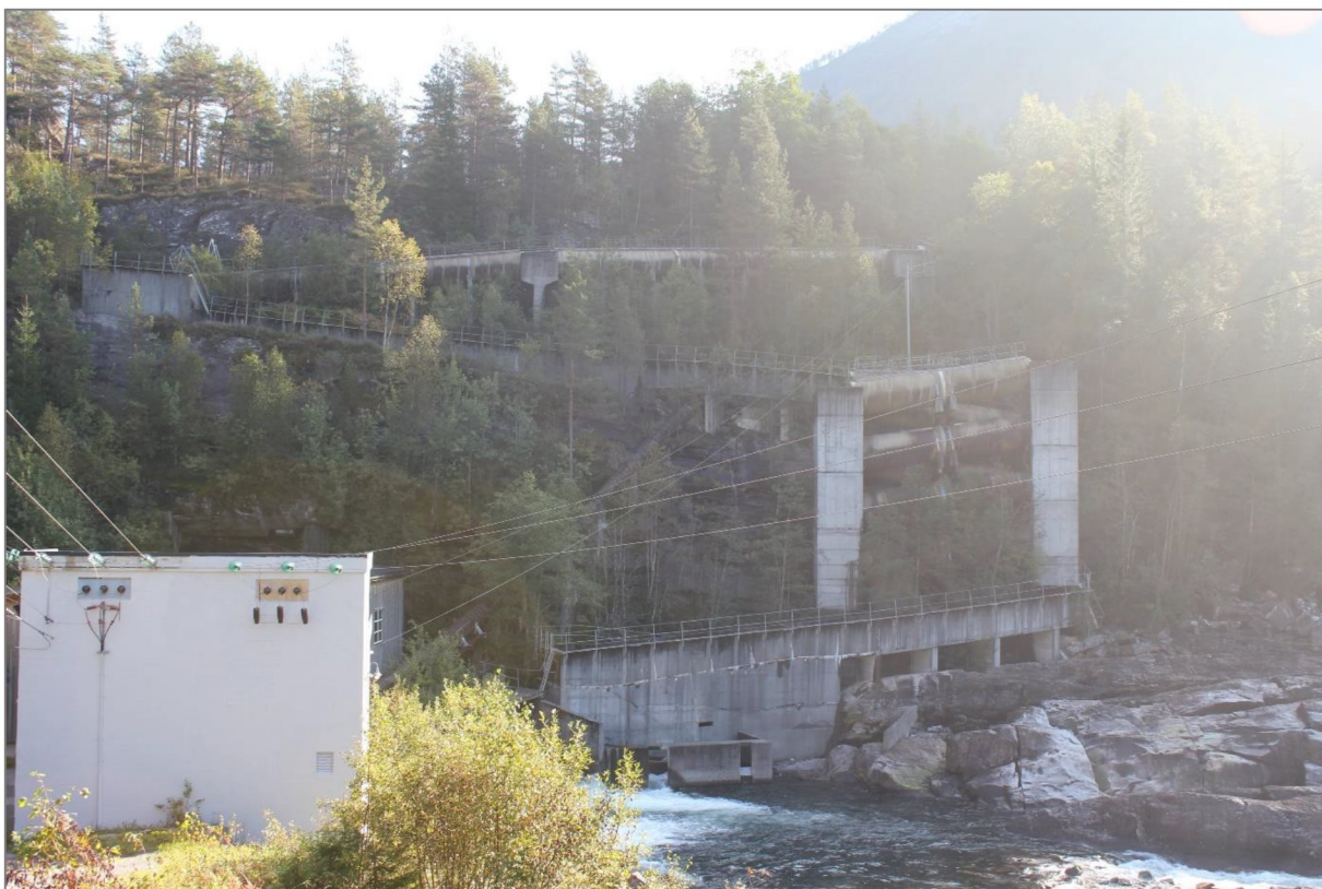
Hellandsfoss kommunale kraftverk til venstre og fisketrappa sentralt i bildet. Foto: Alv Arne Lyse, NJFF.
