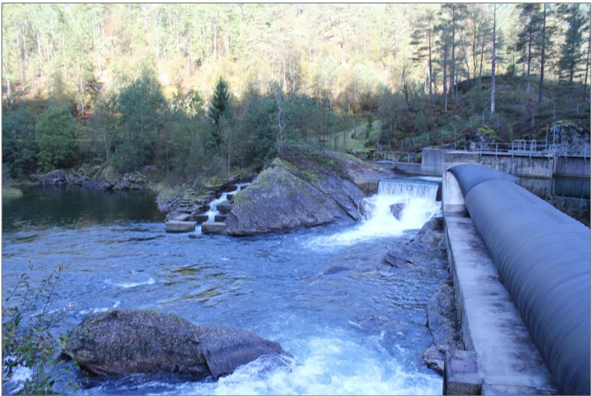
Gummiluka ved Almelid, inntaksdammen til Hellandsfoss kraftverk. Minstevannføring mot Hellandsfossen slippes herfra, og det er i tillegg bygget fisketrapp slik at laks og sjøaure skal kunne passere oppstrøms. Trappa ses i midten av bildet. Foto: Alv Arne Lyse, NJFF.
