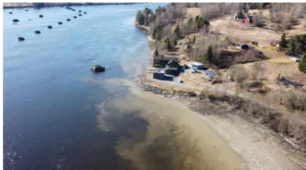
Figur 25 Skråfoto av anlegget tatt fra nord.
