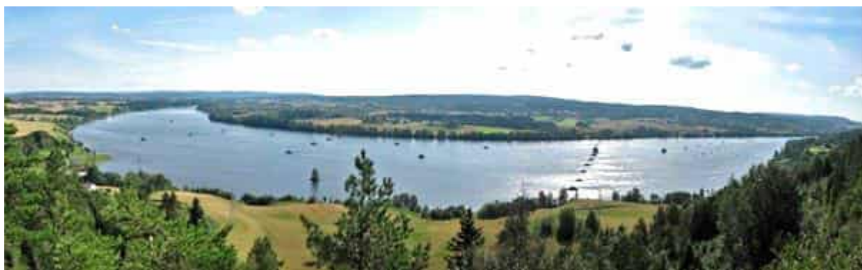
Figur 43 . De gjenværende 51 lensekarene ved Bingen slik de i dag kan ses fra Korpefjellet ved Rømuas utløp. Kilde: Bingen lenser. Foto: Bjørn Rehoff Larsen.
