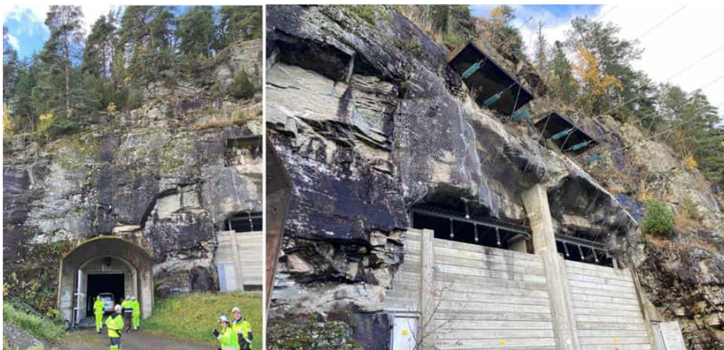
Figur 19 Portal for adkomsttunnelen til PV1 vises til venstre. Portal samt bergrom for eksisterende el.inntak vises til høyre. Nytt reservestrømsaggregat er planlagt til venstre (sør) for adkomsttunnelen.
