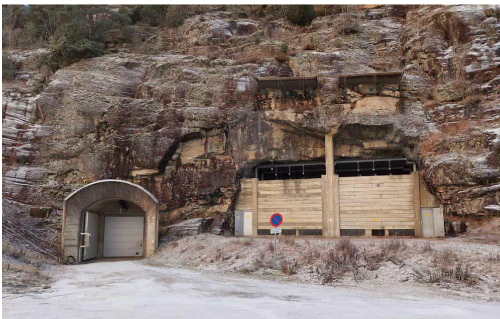
Figur 31 Eksisterende tunnelportal og kraftanlegget i fjellveggen langs Hammergeien nord for daganlegget.
