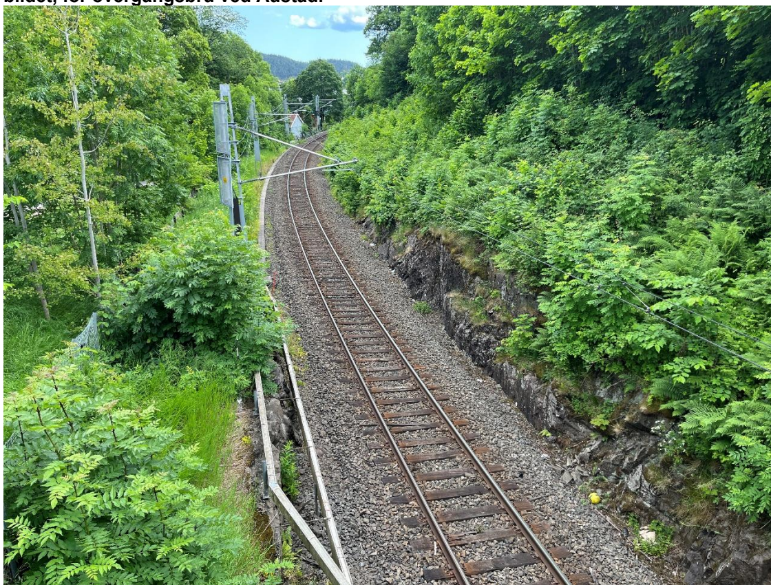
Figur 26: Bilde fra befaring i området 2025-06-18 som viser bergskjæring sett fra broen i retning østover.
