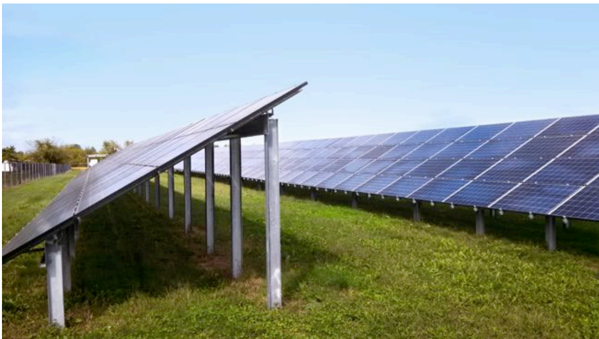
Figur 3-3 Fast-vinkel installasjonsløsning (foto: Willowbrook Solar).
