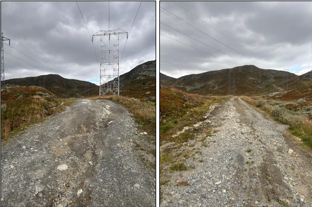
Figur 3-12 Adkomstveien frem til anlegget går delvis under høyspentlinje. Deler av veiens underlag må utbedres, med enten nytt grusdekke eller punktutbedringer. Foto: Sweco Norge.
