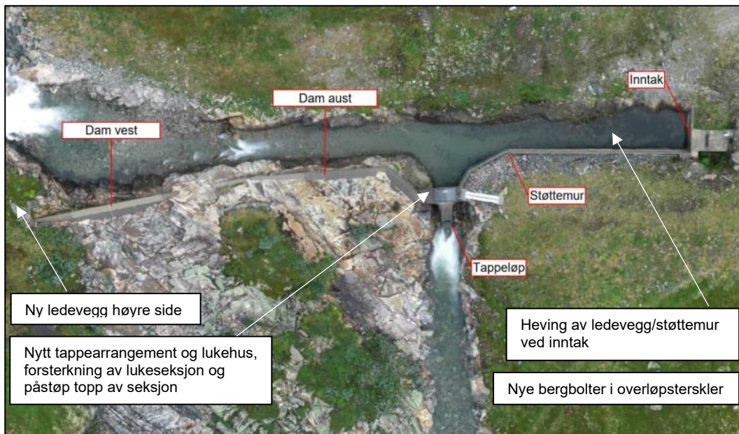
Figur 4-2 Oversiktsbilde over anleggsdelene ved Murane bekkeinntak og tiltak som omfattes av denne planen.
