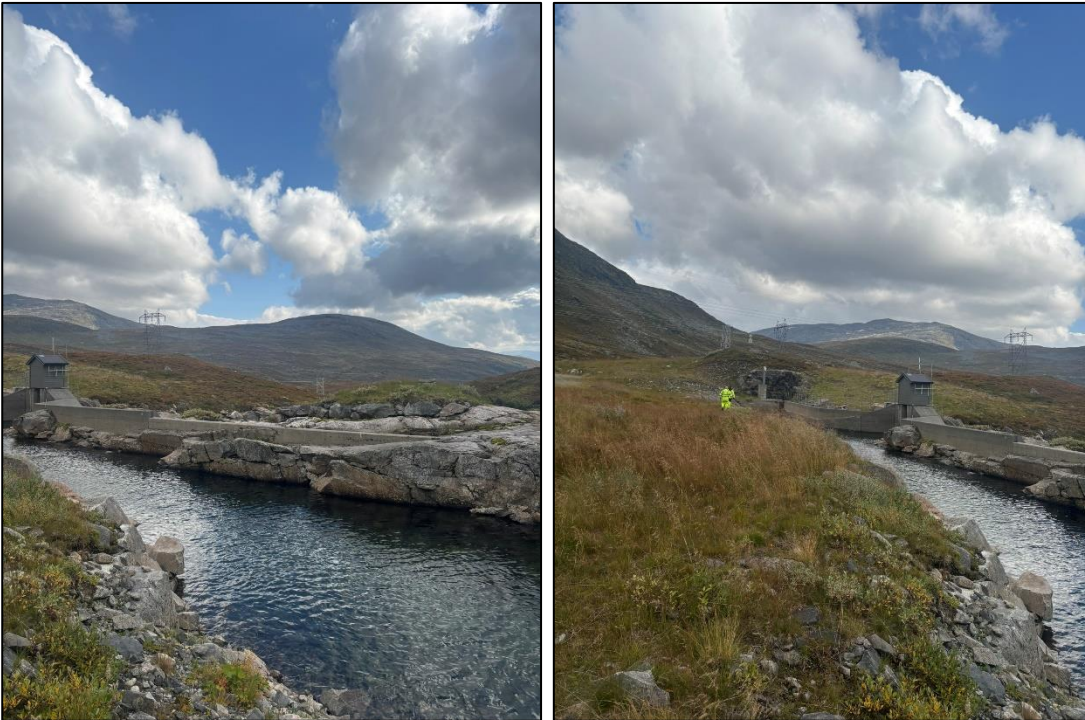
Figur 3-18 Oversiktsbilder av anlegget tatt fra oppstrøms side. Foto: Sweco Norge.
