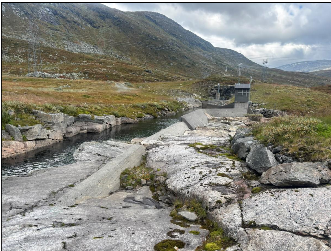
Figur 3-21 Murane bekkeinntak, østre overløpsterskel er delvis støpt inn i berget. Bildet er tatt mot øst. Foto: Sweco Norge.
