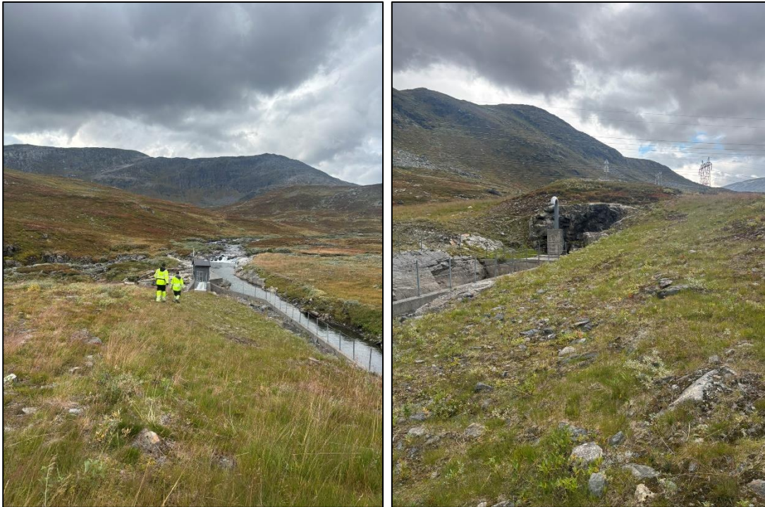
Figur 3-20 Bilder av østre del av anlegget, der anleggets støttemur og ledevegg er delvis tilbakefylt med løsmasser. Foto: Sweco Norge.
