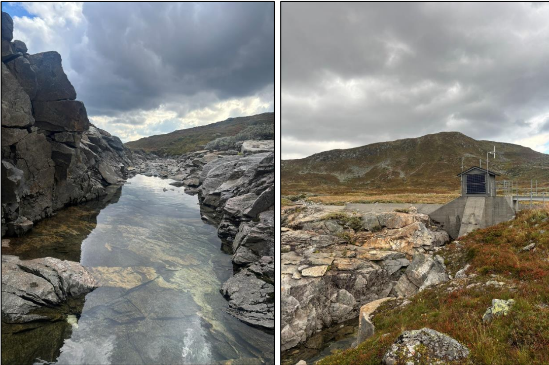
Figur 3-24 Bilder av utløpskanal og terreng nedstrøms dagens tappeluke i anlegget. Foto: Sweco Norge.
