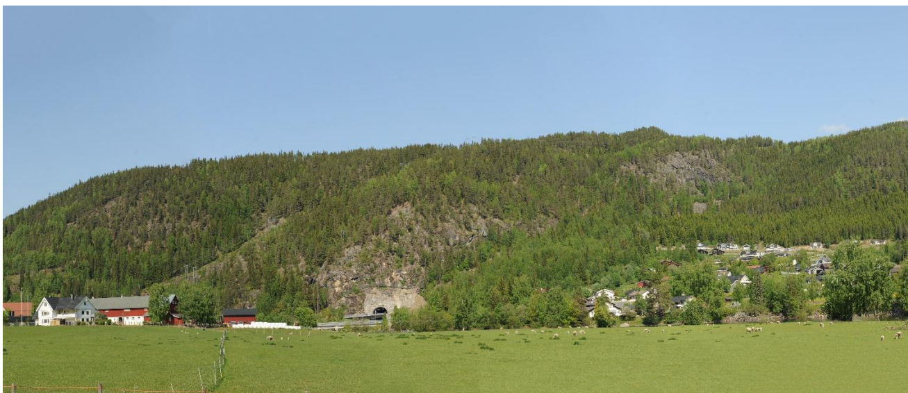
Figur 5-4: Dagens situasjon ved nedføringen til Bagn
