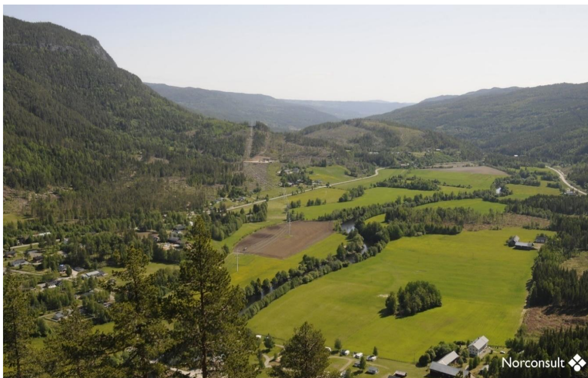
Figur 5-9: Fremtidig situasjon sett fra Flaggfjellet retning øst. Ny ledning er særlig synlig i ryddebeltet til venstre for dagens ledning
