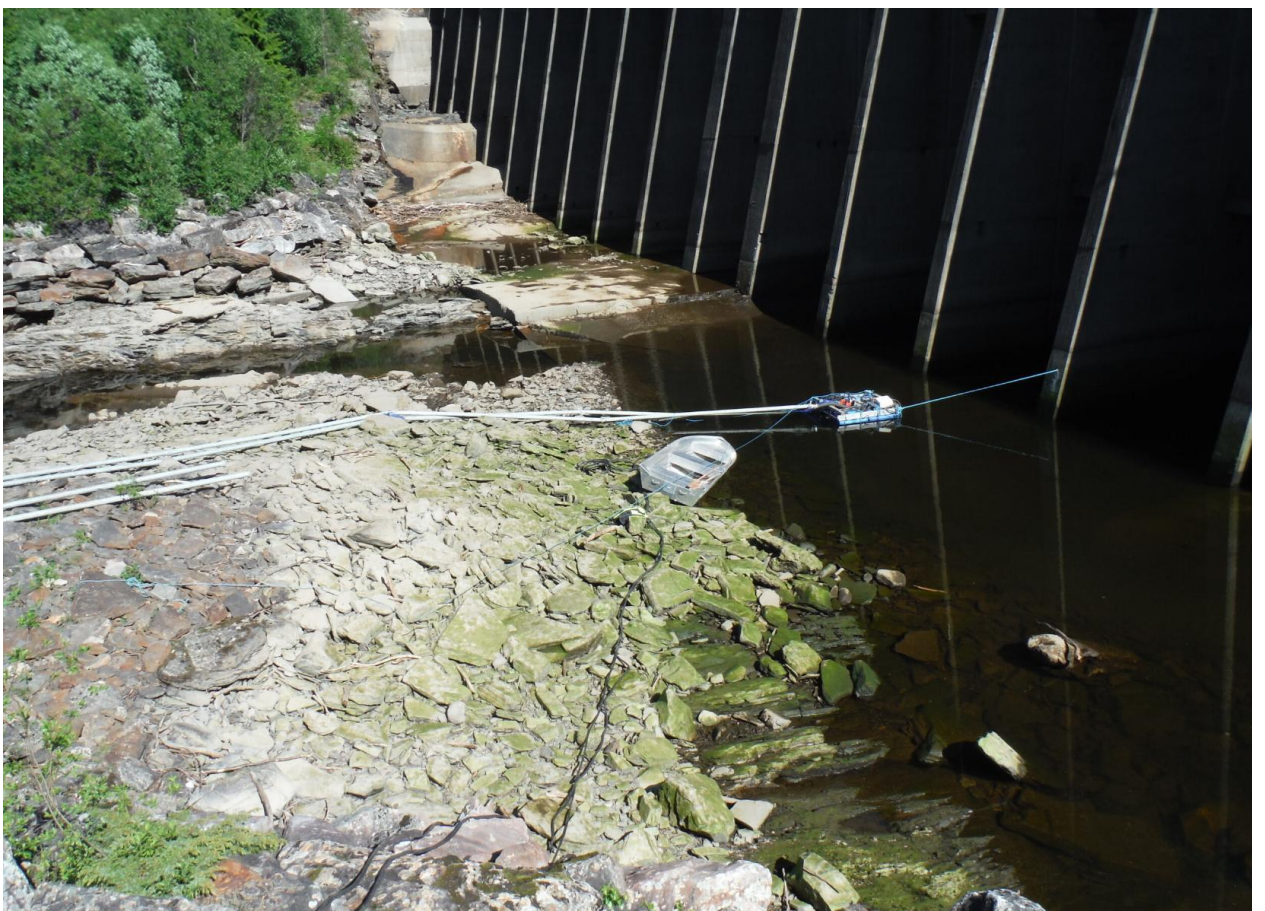
Figur 7 Senkning av vannspeil.
