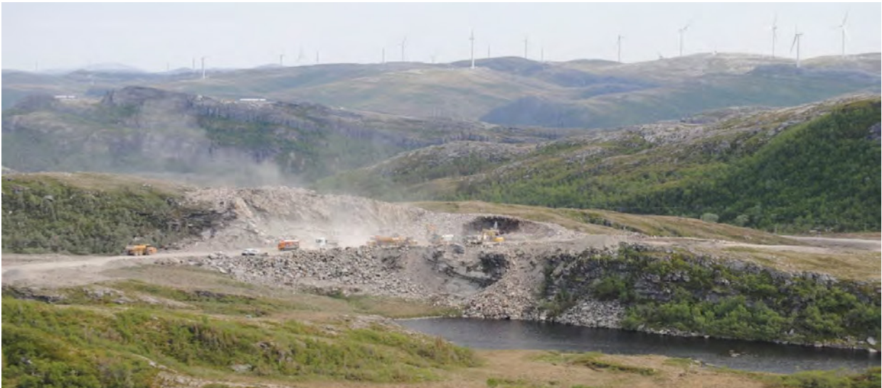
Figur 4-6: Viser plassering av massetak som en integrert del av veiinngrep under utbygging. Kilde: Roan vindkraftverk.
