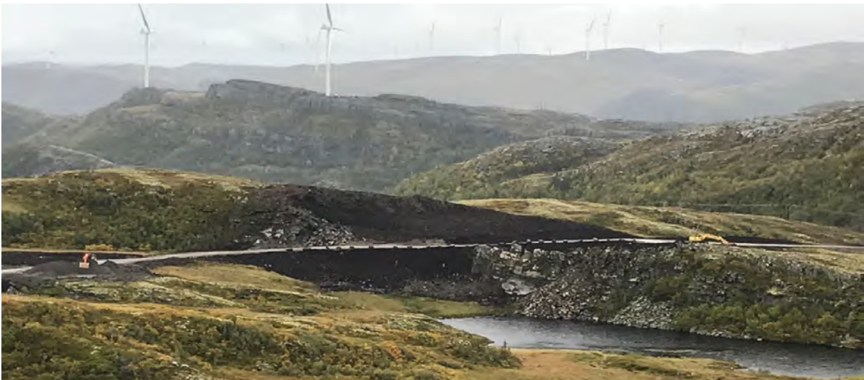
Figur 4-7: Viser plassering av massetak som en integrert del av veiinngrep etter opprydding. Kilde: Roan vindkraftverk.
