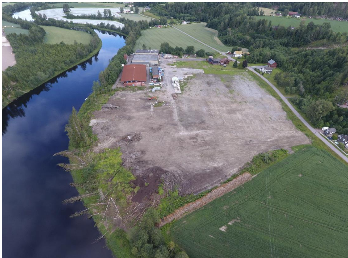
Bilde 7 Oversiktsbilde fra 19.07.2023 som viser oversikt over tomten etter avvirkning av vegetasjon
