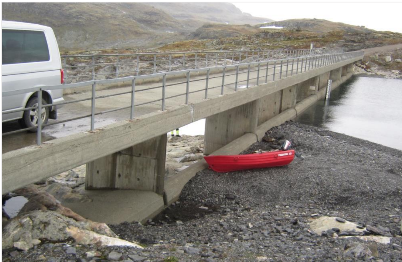
Figur 2-7. Overløpsterskelen ved Nyheller hoveddam
