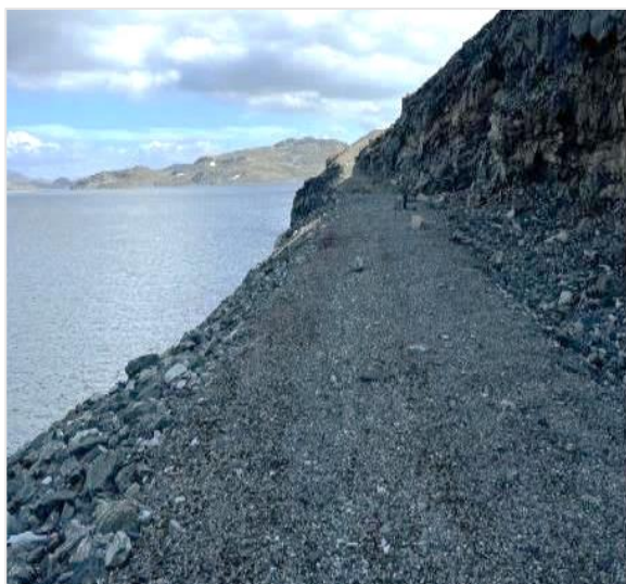
Figur 2-10. Bilde av vegen til lukehuset
