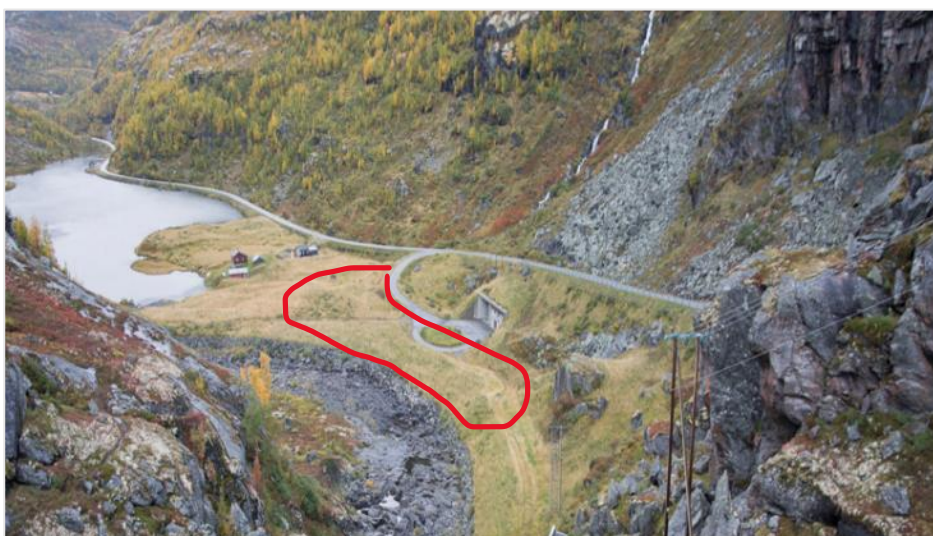
Figur 4-2. Område for boligrigg på Øyestøl. Området består av gresskledde arealer og er enkelt å tilbakeføre.
