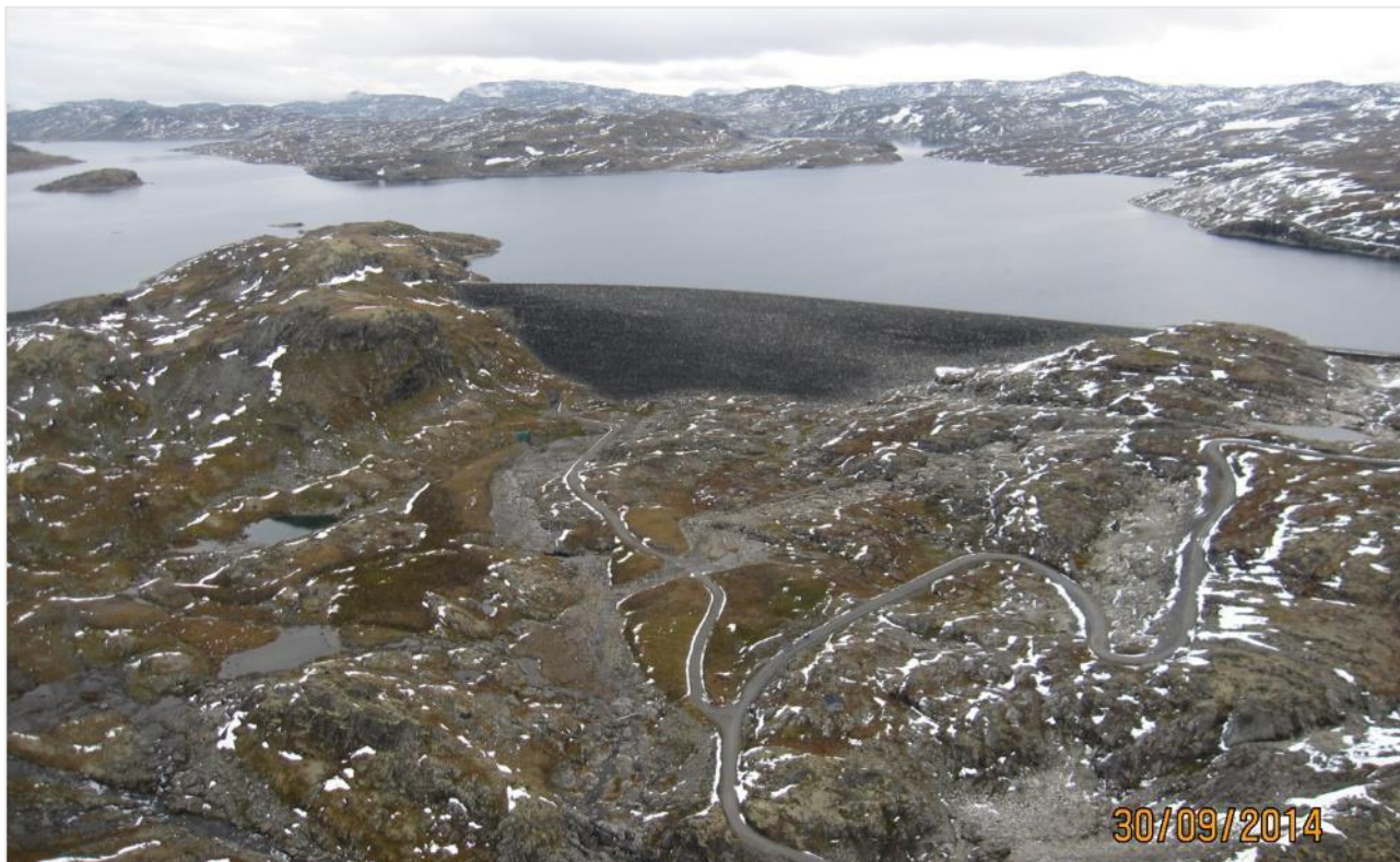
Figur 2-1. Flyfoto som viser Nyheller hoveddam. Overløpsterskel ses helt til høyre i bildet. (Foto: Hafslund Eco)
