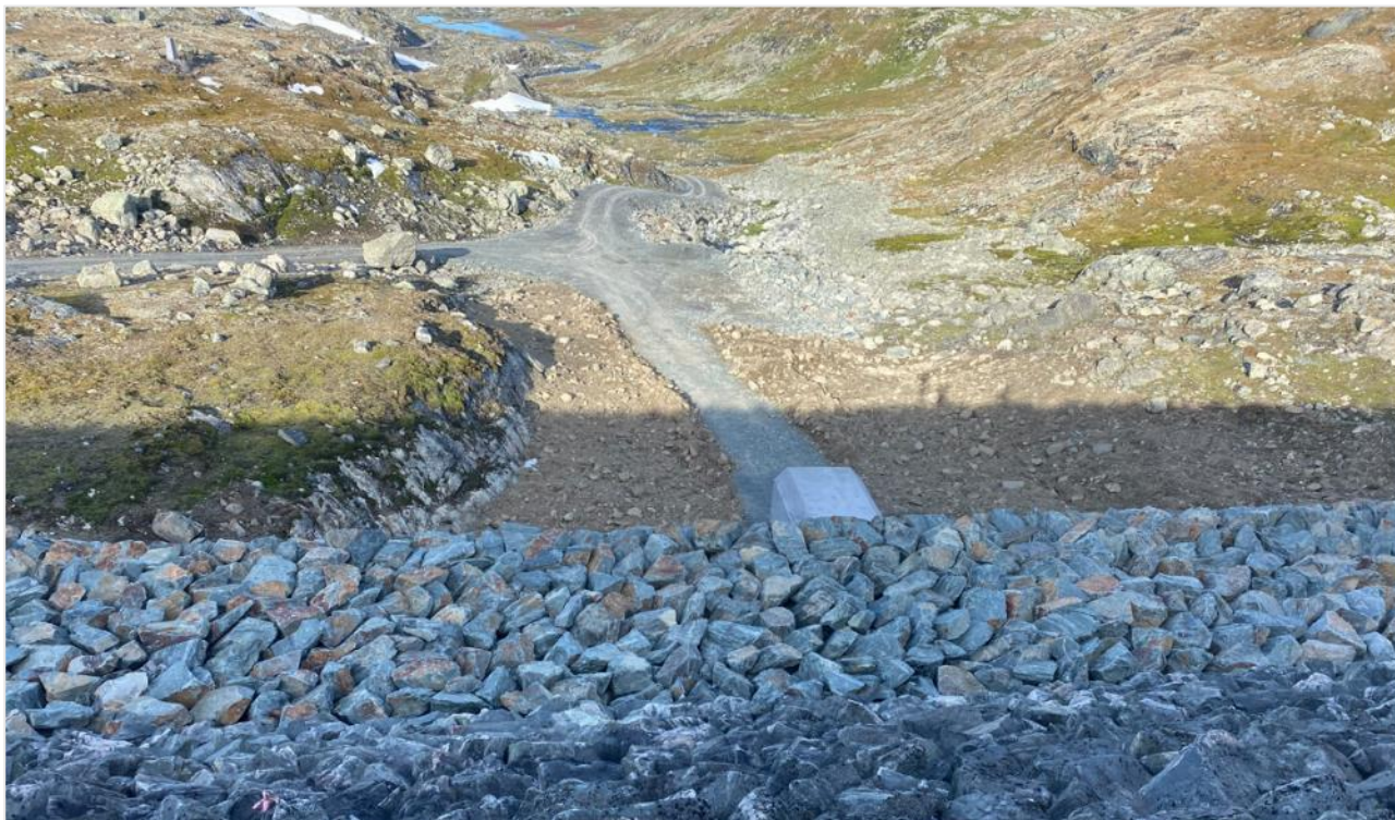
Figur 4-13. Bilde tatt fra sekundærdammen nedover mot nedstrøms side. Veien på bildet ble midlertidig etablert i 2019 og skal brukes under rehabiliteringen av hoveddammen før den fjernes helt.
