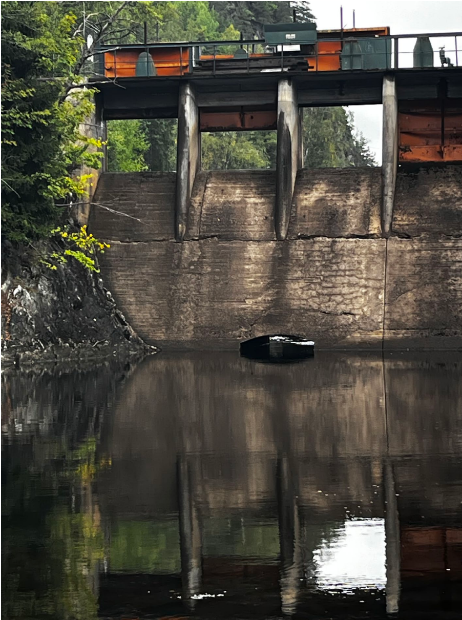
Bunnlukene i Søndeled dam står åpne med fri passasje for fisk Bilde tatt 29.08.2025.
